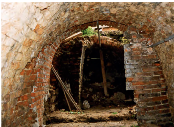
Ryc. 40. Kazimierz, ul. Józefa 19, wykopy budowlane. Ceglane sklepienia i mury barokowej oraz renesansowej piwniczki odkrytej pod wschodnią częścią kamienicy frontowej i pod obecnym podwórkiem. Widok od północy, fot. Emil Zaitz
