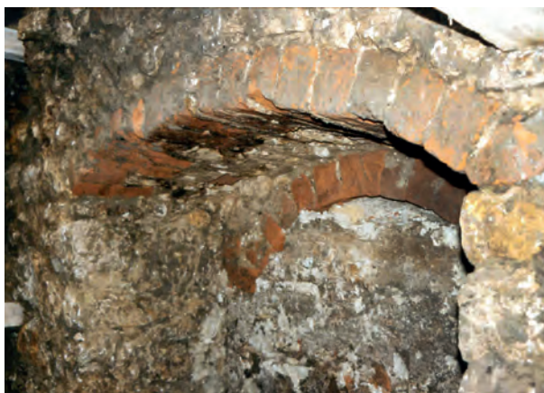
Ryc. 37. Kazimierz, ul. Skawińska 4, wykopy budowlane. Zamurowany otwór drzwiowy w kamiennym murze obiektu B z nadprożem z gotyckiej cegły palcówki. Widok od północnego zachodu, fot. Emil Zaitz
