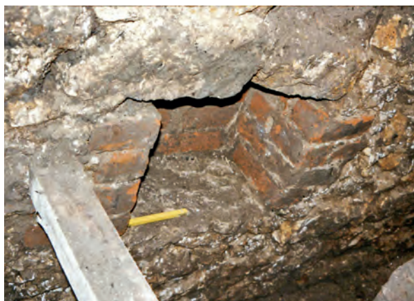
Ryc. 38. Kazimierz, ul. Skawińska 4, wykopy budowlane. Wnęka (almaria) z gotyckiej cegły odkryta w murze obiektu B, z nadprożem wykonanym z dużych kamieni wapiennych. Widok z góry, od północnego wschodu, fot. Emil Zaitz
