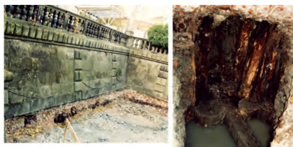
Ryc. 14. Kazimierz, Skalka, sadzawka św. Stanisława. Zachodnia i północna ściana sadzawki z widocznymi wierzchołkami pionowych pali odkrytych pod fundamentem ścian (A) oraz skupisko słupów w przekopie kanalizacyjnym pod murem zachodnim (B). Widok od południa (A) i od wschodu (B), fot. Emil Zaitz
