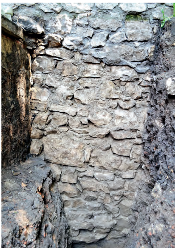
Ryc. 13. Zbliżenie na oryginalny fragment miejskiego muru obronnego średniowiecznego Kazimierza (pierwsza połowa XV w.) odkrytany przy Starej Synagodze, fot. Dariusz Niemiec
