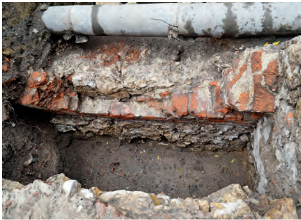
Ryc. 28. Relikty ceglanoego sklepienia nad komorą pieca hypokaustycznego, odsłoniętego w wykopie 7/16, w obrębie północnej części podpiwniczenia domniemanej mykwy z pierwszej połowy XVII w., fot. Dariusz Niemiec
