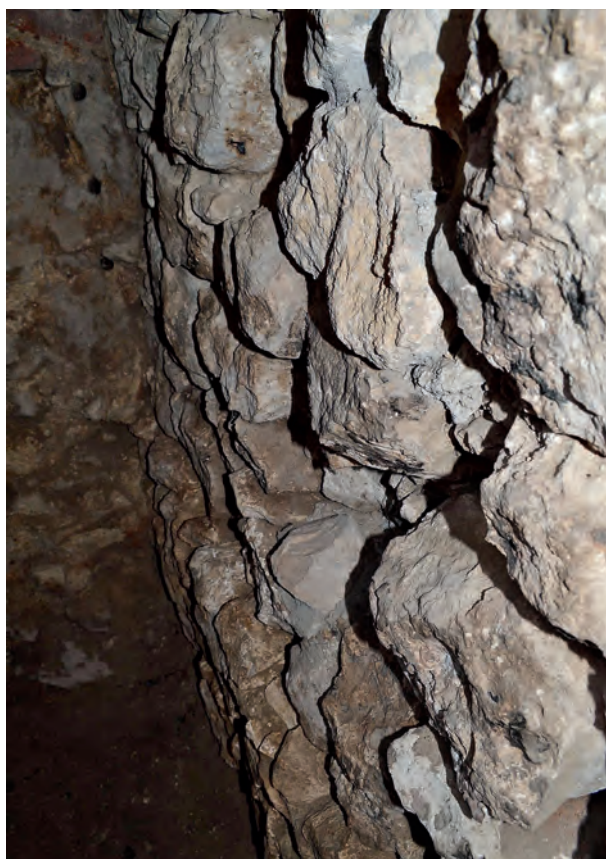
Ryc. 7. Fragmenty gotyckiej ściany i fundamentu pod południowym murem obwodowym Starej Synagogi, fot. Dariusz Niemiec
