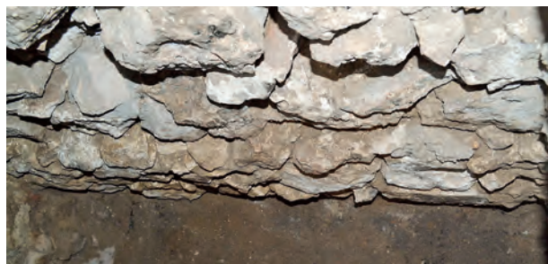
Ryc. 6. Zbliżenie na odsadzkę fundamentową gotyckich relikwiarzy Starej Synagogi odsłoniętych pod ścianą południową bożnicy, fot. Dariusz Niemiec
