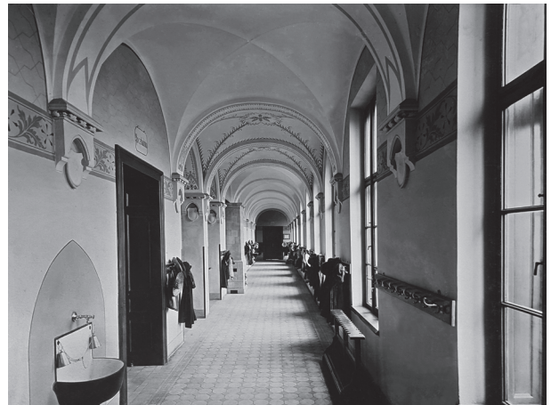
Korytarz szkoły przy ul. Wąskiej; w zasobie ANK, ABM, TJZ, MI-41, il. 29
