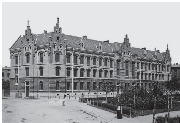
Szkoła miejska przy ul. Dietla 70 według projektu Stefana Żołdania, fot. Natan Krieger; w zbiorach MHK, nr inw. MHK-1208/K
