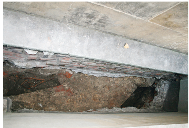
Ryc. 14. Południowo-zachodni odcinek kanału. Apsyda kaplicy Pileckich – południowy odcinek z fragmentem cokołu narożnej przypory i południowo-zachodni odcinek z ceglany wykończeniem w styku ścian. Przy fundamencie kaplicy Lubomirskich uszkodzony grób (?) ze szkieletem ludzkim, fot. M. Goras
