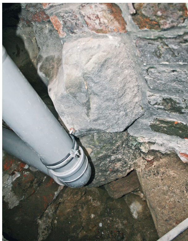
Ryc. 16. Południowo-zachodni odcinek kanału. Fragment obciętego cokołu przypory kościoła z trzech nalożonych na siebie ciosów kamienia. Kamienny cokół kaplicy Pileckich (z prawej) dostawiony w miejscu wyciętego cokołu, fot. H. Rojowska
