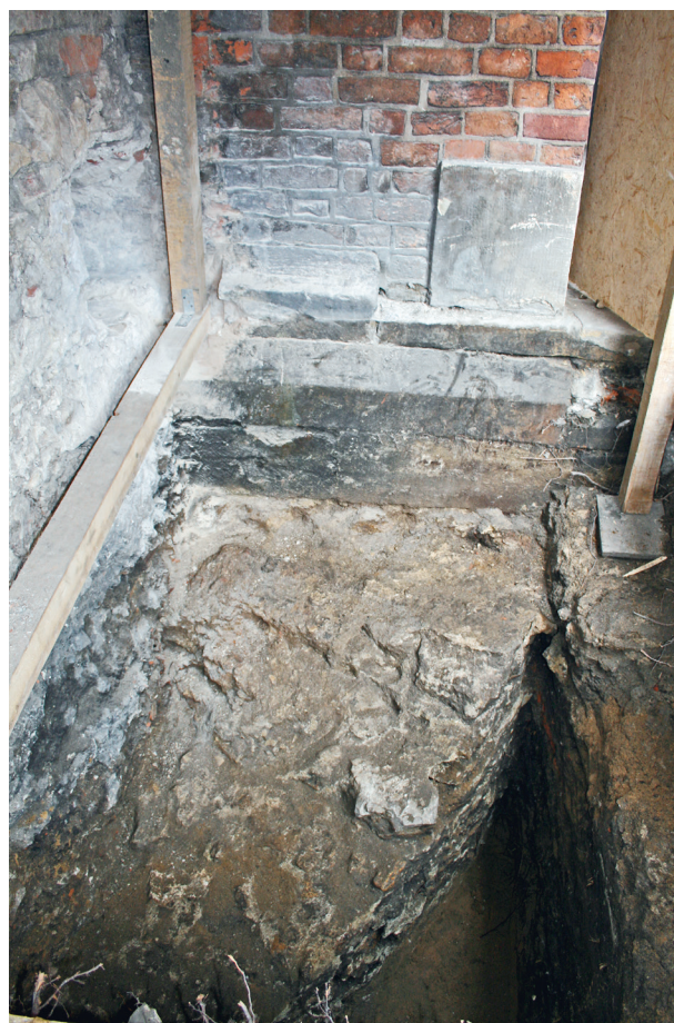
Ryc. 5. Wykop przed elewacją zachodnią. W wykopie fragment kolistej wieży z posadowionym na niej kamiennym cokolem nawy i z lewej strony fundamentem kaplicy Zbaraskich, fot. H. Rojkowska
