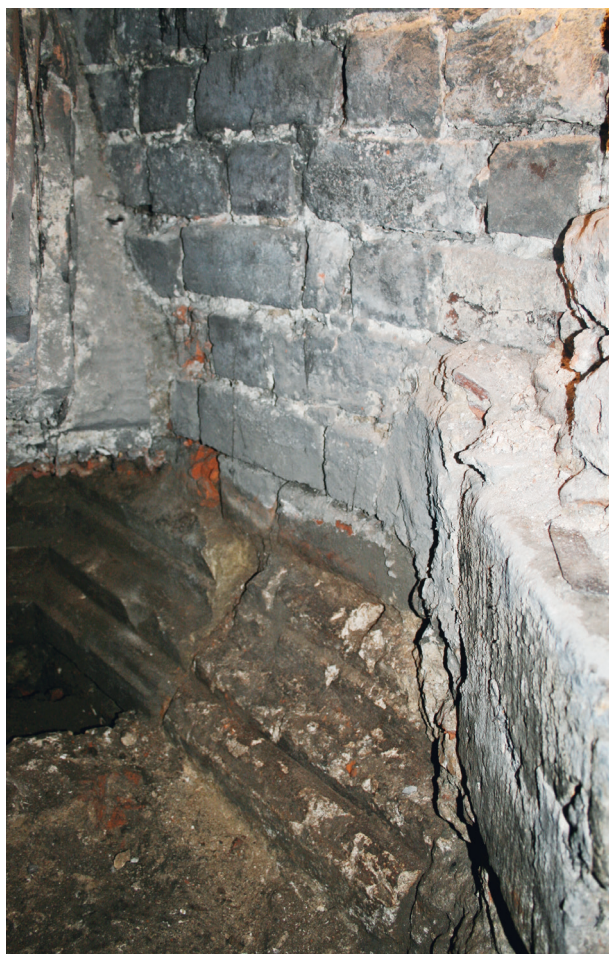
Ryc. 9. Północno-wschodnia część kanału. Fragment przypory gotyckiej kaplicy św. Katarzyny z profilowanym cokolem i dostawiony do niej fragment późniejszej ściany furty z kamiennym ciosem. Na cokole widoczna cezurą i zniszczona partia zasłonięta wcześniej murem kamiennie-ceglanym, fot. M. Goras
