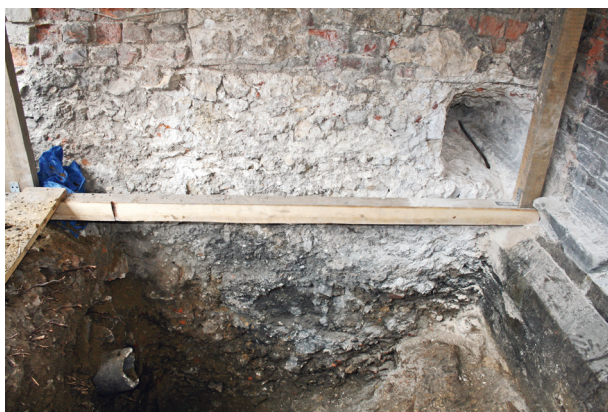
Ryc. 6. Wykop przed elewacją zachodnią. Kamienny fundament południowej ściany kaplicy Zbaraskich, w górnej partii z gotyckiej cegły rozbiórkowej z kamiennymi podstawami pod narożne pilastry, fot. H. Rojkowska
