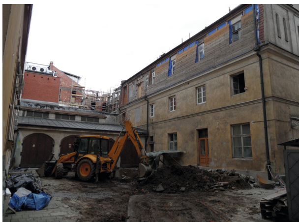
Widok budowli od strony dziedzińca w trakcie prac, 2010, fot. A. Gawrońska
