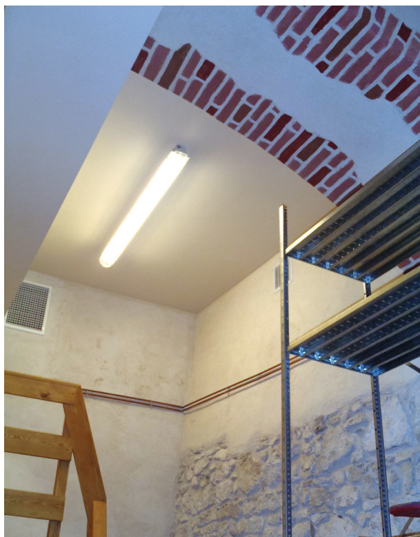
Relikty wcześniejszej zabudowy w piwnicach, fragment ceglano- łęgu, 2012, fot. K. Glanowska
