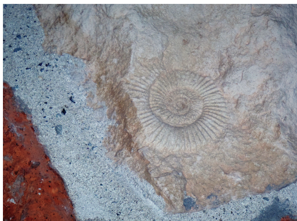
Odcisk amonitu utrwalony w strukturze wapiennego fragmentu murów w piwnicy, 2012, fot. K. Glanowska
