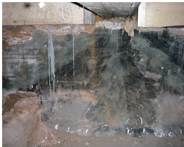
Fryz pod podłogą na drugim piętrze, ściana wschodnia, stan przed konserwacją, 2007, fot. W. Stefańska
