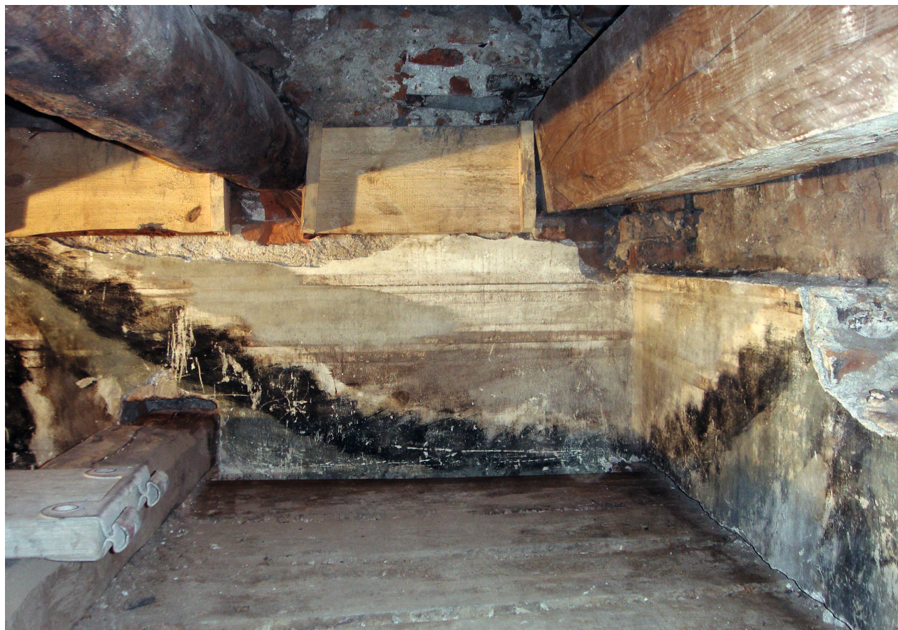
Fryz w narożniku południowo-wschodnim, stan po oczyszczeniu, 2007, fot. W. Stefańska
