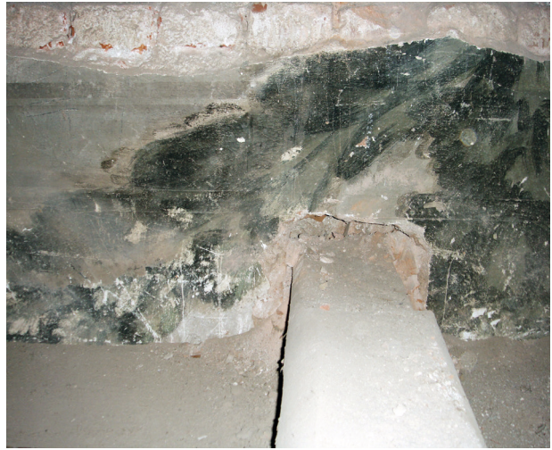
Fryz pod podłogą na drugim piętrze, ściana zachodnia, stan przed konserwacją, 2007, fot. W. Stefańska
