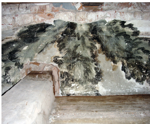
Fragment fryzu na ścianie zachodniej po oczyszczeniu, 2007, fot. W. Stefańska
