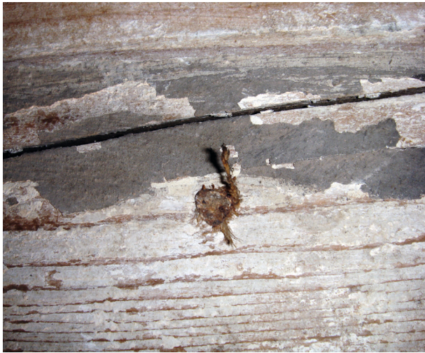
Fragment oryginalnej belki przy ścianie południowej, stan z 2007 r., fot. W. Stefańska
