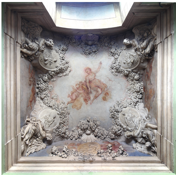
Widok ogólny na strop kaplicy, fot. T. Kalarus
