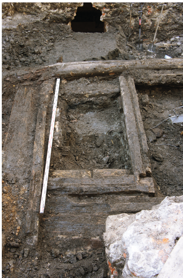
Ryc. 7. Dziedziniec pałacu Pod Krzysztoforą; pozostałości średniowiecznych niewielkich budynków gospodarczych o konstrukcji zrębowej; widok od wschodu, fot. R. Górski;
