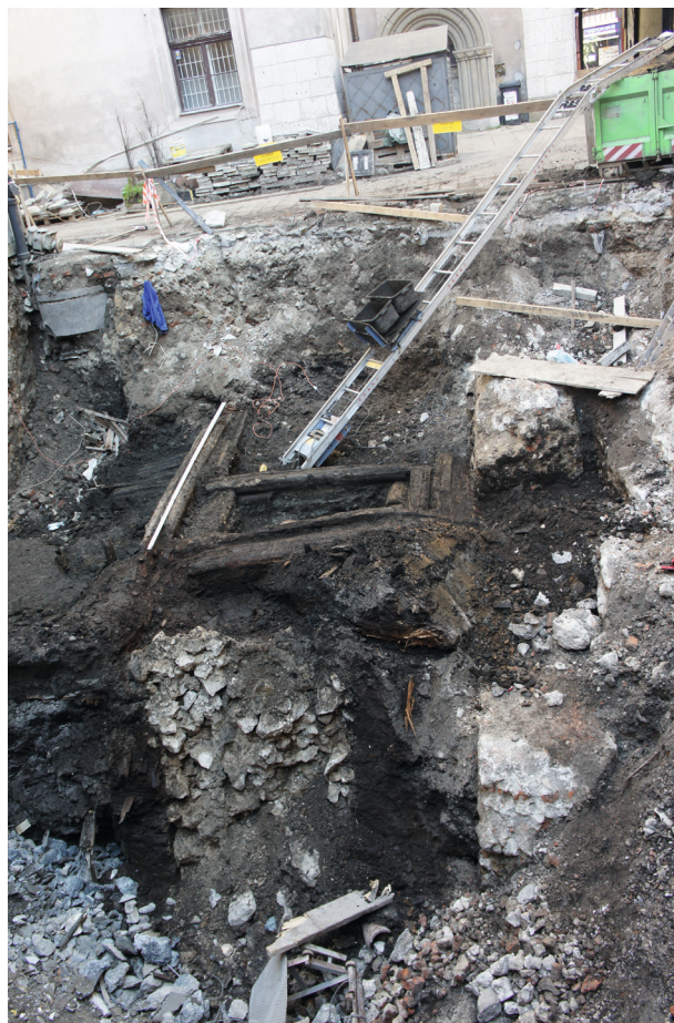
Ryc. 13. Dziedziniec pałacu Pod Krzysztofory; widok ogólny wykopu od strony południowej; w części centralnej widoczna pozostałość kamiennej ściany lub filara, fot. R. Górski
