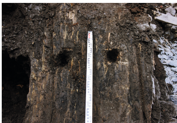
Ryc. 10. Dziedziniec pałacu Pod Krzysztoforą; relikty średniowiecznych drewnianych budynków gospodarczych – widoczne detale konstrukcyjne (otwory do osadzania drewnianych czopów mocujących), fot. R. Górski
