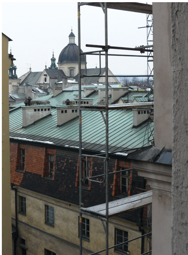
Oficyna przed remontem, 2010, fot. I. Palca
