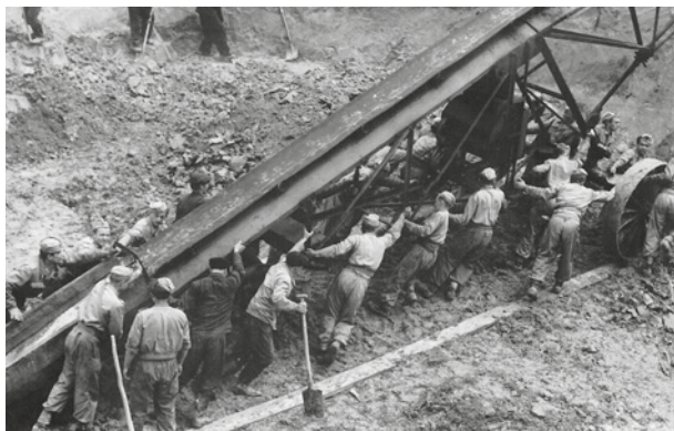
Wykop pod fundamenty komina Baterii Koksowej nr 1 w Pleszowie. Gleby, na których wznoszono kombinat i Nową Hutę, składały się z czarnoziemu lessowego. Były bardzo lepkie i podczas niepogody szybko zamieniały się w głębokie błoto, co utrudniało wszelkie prace, ok. 1950 r., fot. M. Gładysiek; w zbiorach Muzeum Historycznego Miasta Krakowa, sygn. MHK 229/XI f
