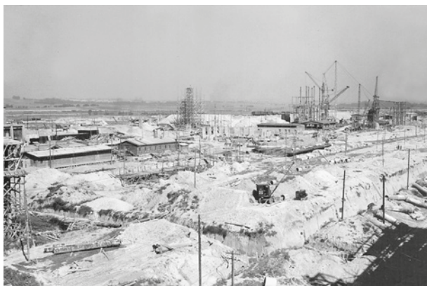
Wykopy w rejonie budowy aglomerowni, 16 lipca 1953 r.; w zbiorach Muzeum Historycznego Miasta Krakowa, nr inw. MHK 236/XI f
