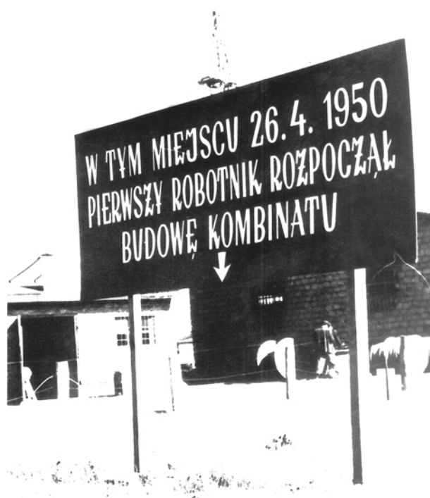
Tablica upamiętniająca miejsce rozpoczęcia budowy kombinatu metalurgicznego. Znajdowała się ona przy budynku garaży i dyrekcji, które nie zachowały się. Na tym miejscu wznosi się obecnie hala Walcowni Karoseryjnej buty Arcelor Mittal (dawnej Huty im. W. Lenina). Fotografia była często reprodukowana, szczególnie w publikacjach dotyczących kolejnych rocznic powstania nowohuckiego kombinatu, lata 50. XX w.; w zbiorach Muzeum Historycznego Miasta Krakowa, nr inw. MHK 213/XI f
