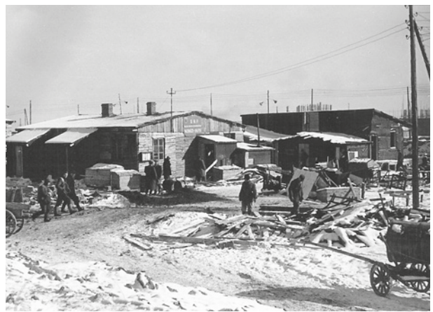
Plac budowy Aglomerowni, barak administracji, 10 lutego 1953 r.; w zbiorach Muzeum Historycznego Miasta Krakowa, nr inw. MHK 235/XI f
