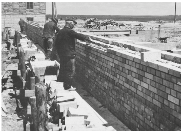
Budowa warsztatu służby drogowej, obiekt nr 116, dokumentacja radziecka, 1950 r.; w zbiorach Muzeum Historycznego Miasta Krakowa, nr inw. MHK 222/XI f
