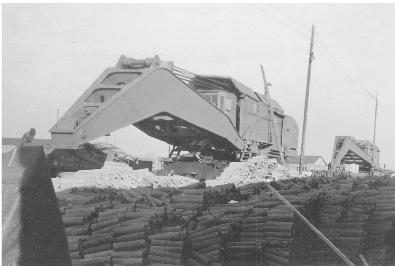
Radziecki dźwig kolejowy 50-tonowy na głównym placu budowy kombinatu, 10 stycznia 1951 r.; w zbiorach Muzeum Historycznego Miasta Krakowa, nr inw. MHK 260/XI f
