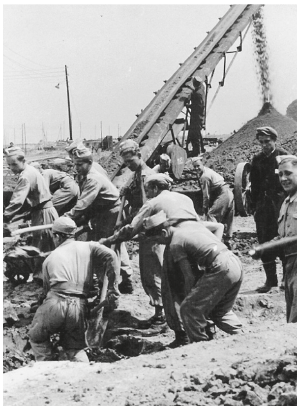
Junacy Służby Polsce przy wykopach pod fundament komina dla budynku Wydziału Siłowni (obecnie Zakład Energetyczny), 15 maja 1952 r.; w zbiorach Muzeum Historycznego Miasta Krakowa, nr inv. MHK 228/XI f
