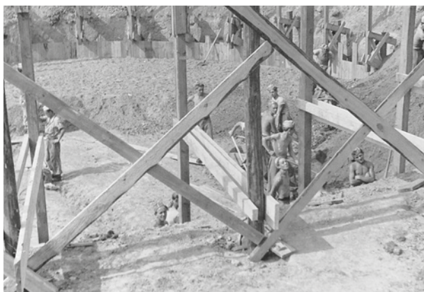
Wykopy pod zbiornik wodny kombinatu w Krzesławicach. Pracują junacy Służby Polsce, 4 września 1951 r.; w zbiorach Muzeum Historycznego Miasta Krakowa, sygn. MHK-227/XI f
