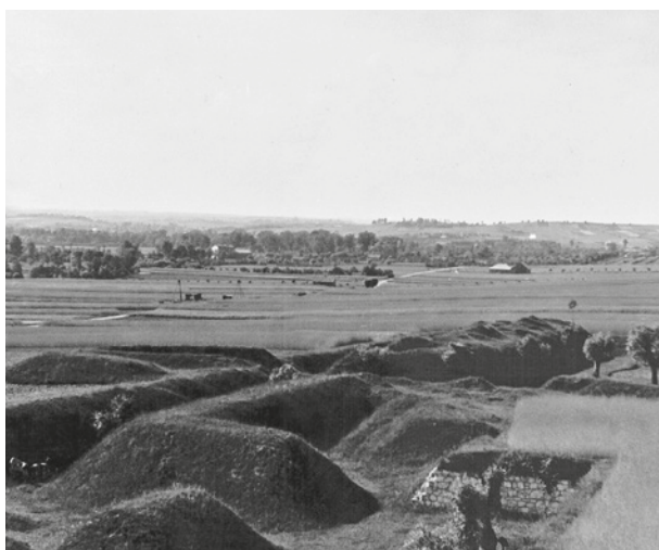
Teren budowy widziany z kopca Wandy. Obiekty na pierwszym planie to niezachowane fortyfikacje dawnego Fortu Wanda, otaczającego niegdyś kopiec. Widoczny w centrum kadru wysoki budynek to młyn Finkelsteinów w Mogile-Kopaniu, zwany Gwoździarnią, 1950 r.; w zbiorach Muzeum Historycznego Miasta Krakowa, nr inw. MHK 205/XI f
