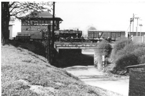
Po elektryfikacji węzła krakowskiego w latach 1959–1960, jeszcze długo widok pracującego parowozu urozmaicał kolejowy krajobraz. Amerykański (otrzymany w ramach pomocy UNRRA) parowóz serii Tr 203 podczas prac manewrowych w rejonie wiaduktu nad ul. Łokietka. W tle była nastawnia KTA – w tym czasie obiekt mieszkalny, maj 1961 r.; w zbiorach D. Lulewicza
