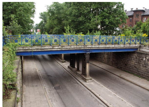
Zespół oryginalnych wiaduktów z lat 1910–1912 nad ul. Prądnicką. Zwracają uwagę odnowione zgodnie z pierwotną kolorystyką balustrady. Z prawej strony budynek mieszkalny przy ul. Zbożowej 5/7; fot. D. Lulewicz, 5 sierpnia 2009 r.
