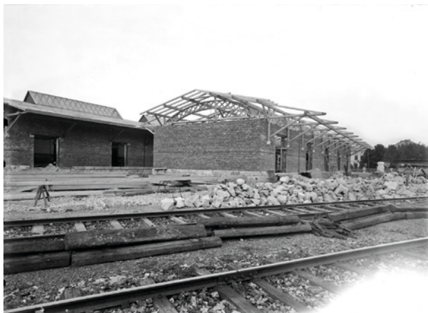
Budowa większego magazynu zbiorowego, 1912 r. Z lewej strony magazyn celny (ze świetlikami w dachu); w zbiorach Muzeum Historii Fotografii, sygn. 18288/II
