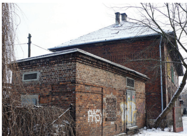
Przebudowany w okresie powojennym i pozbawiony oryginalnego zadaszenia budynek transformatora przy ul. Składowej; fot. D. Lulewicz, 25 lutego 2011 r.
