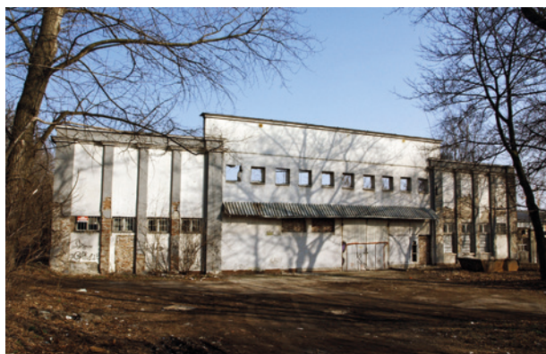
Ożywiona pilastrami i wydatnymi gzymsami ściana szczytowa samochodowni PKP. Jedyńy czytelny architektonicznie fragment spalonego w 2000 r. budynku; fot. D. Lulewicz, 22 marca 2011 r.
