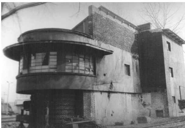
Pokrewny stylistycznie nastawni KTA, obiekt przy ul. Zbożowej, stan przed adaptacją, marzec 1987 r.; w zbiorach D. Lulewicza
