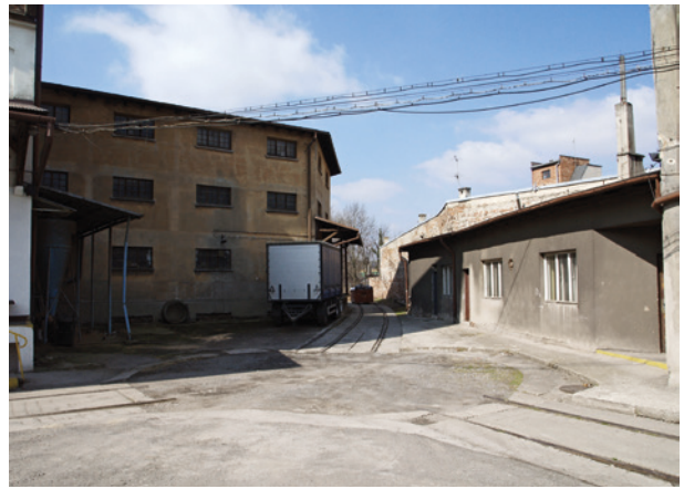
„Negatyw” po rozebranej ok. 2000 r. obrotnicy talerzowej na terenie Centrali Nasiennej; fot. D. Lulewicz, 23 marca 2011
