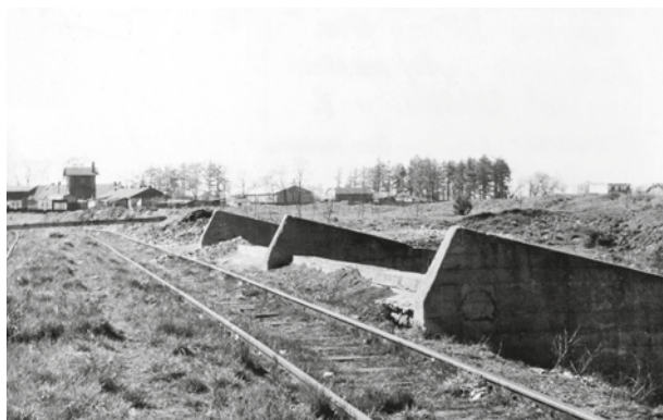
Zsypy węglowe w północnej części dworca wstępnego. Widoczne betonowe przegrody, górna krawędź usypiska oraz tor węglowy. W tle zespół zabudowań z widoczną wieżą wodną pierwszej stacji kolei cyrkumwalacyjnej, maj 1961 r.; w zbiorach D. Lulewicza
