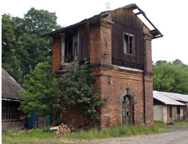
Jedyna pozostałość po pierwszej stacji kolei cyrkumwalacyjnej – wieża wodna z nitowanym zbiornikiem wodnym. Jeden z dwóch tego typu obiektów na terenie węzła krakowskiego; fot. D. Lulewicz, 5 sierpnia 2009 r.
