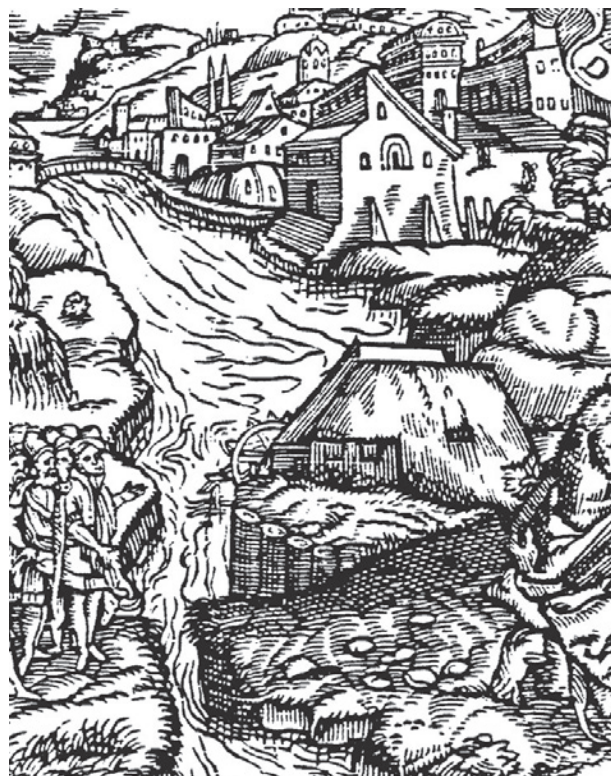
Ryc. 3. Sposób zabezpieczenia brzegów rzeki drewnianymi palami – kasztowaniem; reprodukcja: Crescentyn P.: O pomnożeniu y rozkrzewieniu wszelkich pożytkow ksiąg dwoienascie. Kraków 1571, s. 276
