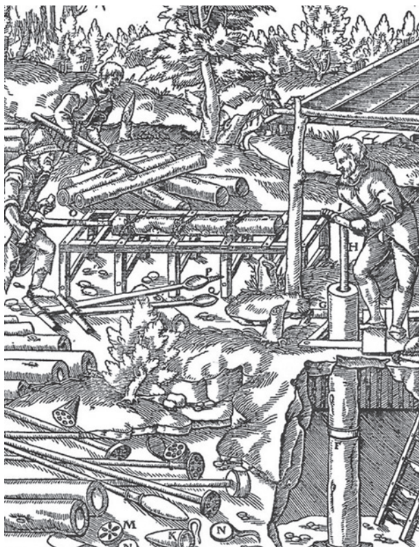
Ryc. 9. Wiercenie drewnianych rur wodociągowych, obok widoczne różne rodzaje świrdrów; reprodukcja: Agricola G.: De re metallica libri XII . London 1912, s. 177
