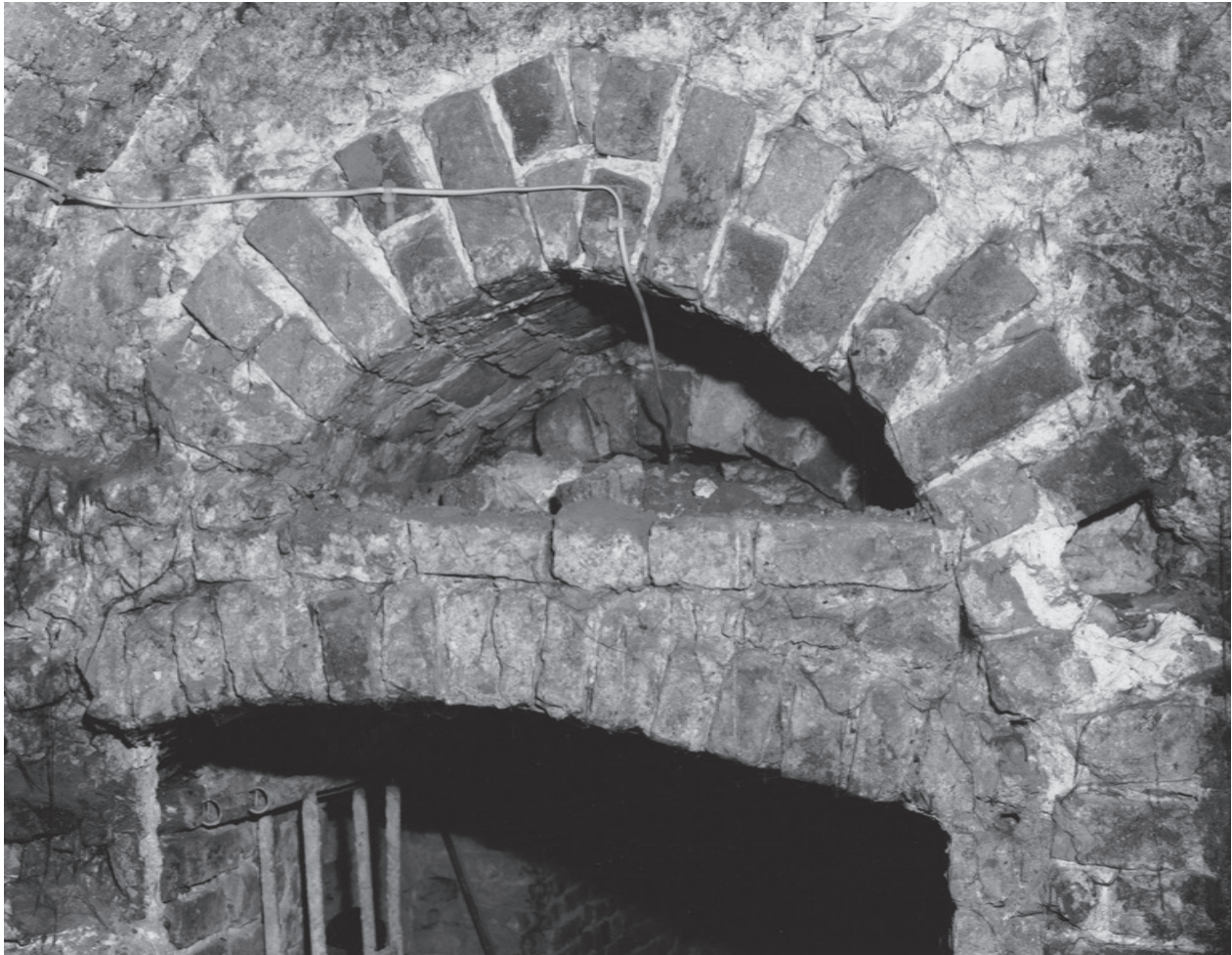
Ryc. 5. Rynek Główny 36 / ul. Sławkowska 1. Wnętrze wieży, wnęka pierwotnego otworu, wtórnie przebudowanego, widoczne ostrołukowe zamknięcie wnęki od strony wnętrza oraz w głębi fragment ceglano obramienia otworu o łuku pełnym; fot. T. Kalarus
