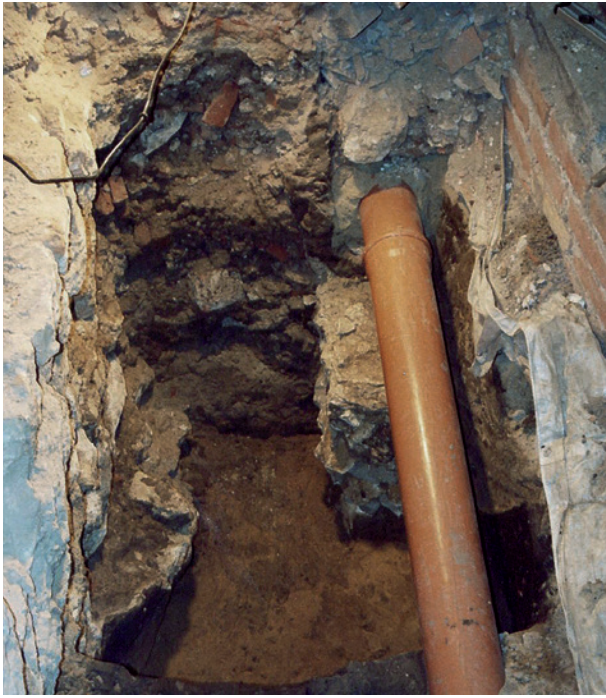
Ryc. 46. Korytarz po wschodniej stronie krzyża Sukiennic, wykop 32. Relikty muru wczesnogotyckiej budowli odkrytej pod instalacjami kanalizacyjnymi i teletechnicznymi z XX w. Z lewej fundament muru zbudowanego przez T. Prylińskiego z lat 1875–1879. Widok od północy; fot. E. Zaitz
