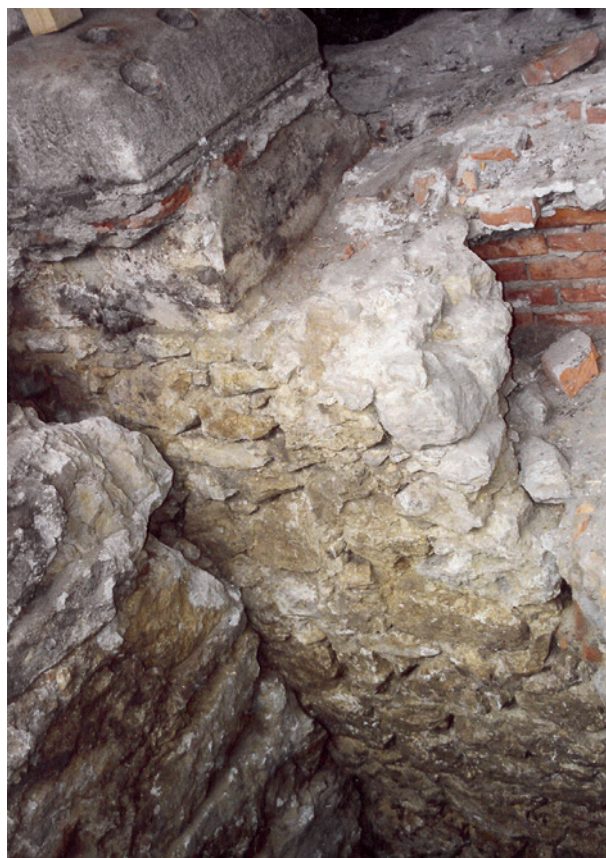
Ryc. 7. Północna część Sukiennic, wykop 17 i 33. Fundament północnej ściany Sukiennic z drugiej połowy XIV w. oraz dostawiony do niego mur renesansowego filara. Na koronie gotyckiego muru ciosy arkady bramnej, z prawej zamurówka z cegły maszynowej w miejscu uszkodzonym przez kanał blokowy. Widok od północnego-zachodu; fot. E. Zaitz
