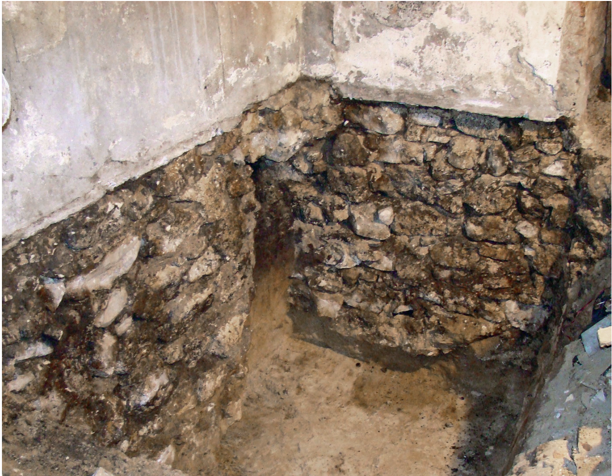
Ryc. 24. Północna część hali Sukiennic, sonda 2, korytarz. Dostawione do siebie gotyckie ławy fundamentowe wschodniego skrzydła Sukiennic (z prawej) i muru zamykającego halę od północy (z lewej). Między nimi zachowały się resztki nawarstwień i piasku calcowego. Pod partią otynkowaną w XX w. oba mury były związane z sobą. Widok od południowo-zachodu; fot. E. Zaitz
