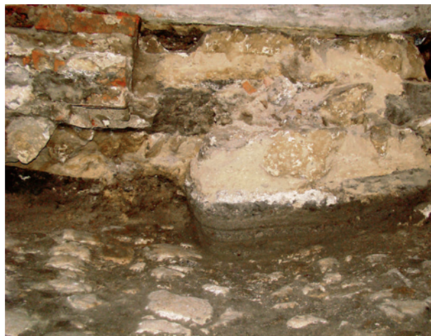
Ryc. 18. Północna część hali Sukiennic, wykop 34. Fundament renesansowego muru poprzecznego oraz resztki bruków kamiennych z okresu budowy Sukiennic i z renesansowej przebudowy obiektu. U dołu część nawierzchni osuniętej wraz z innymi nawarstwieniami do wykopu budowlanego ściany ceglanej z XX w. Widok od północy; fot. E. Zaitz
