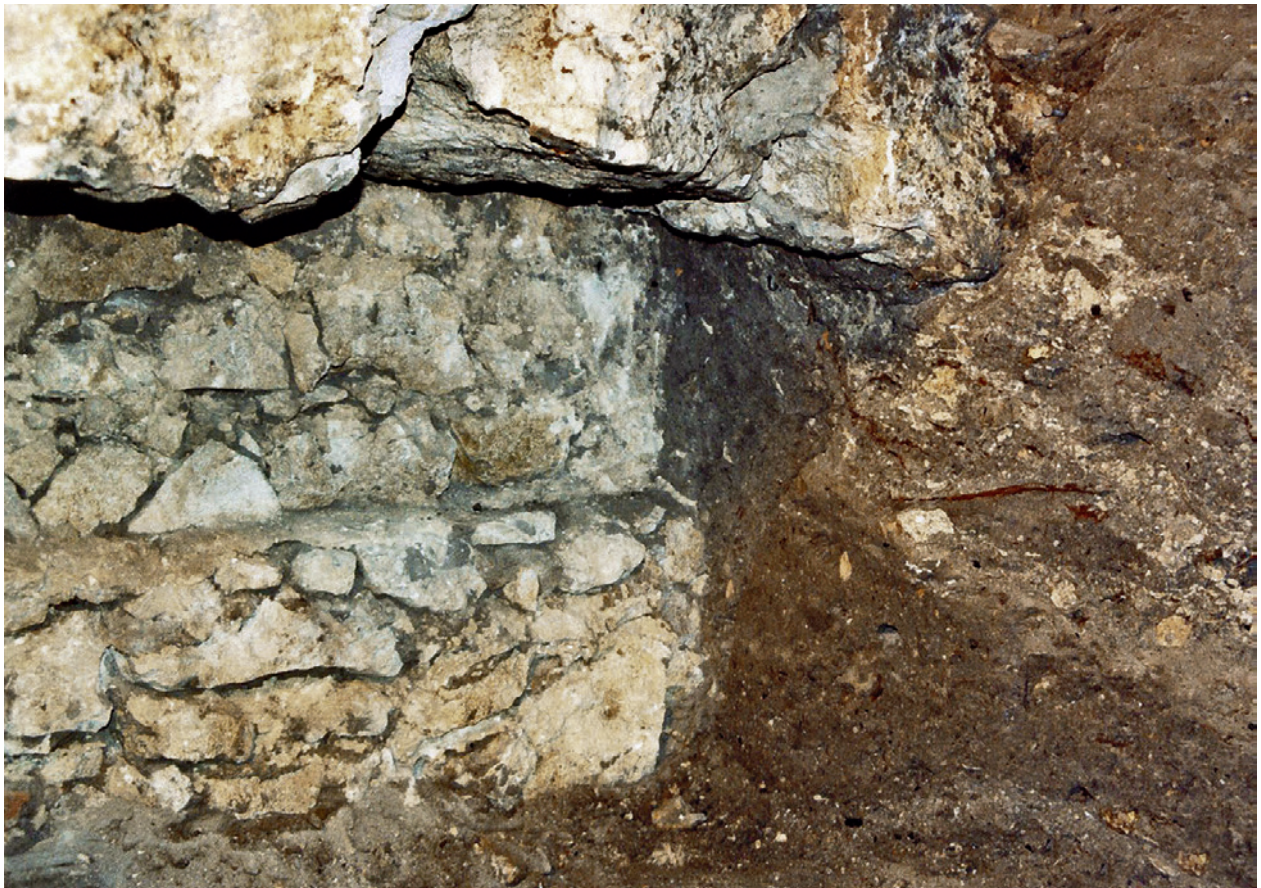
Ryc. 48. Zachodnia część krzyża Sukiennic, wykop 31 (odcinek D). Lico północne muru gotyckich Sukiennic zbudowanych w drugiej połowie XIV w. oraz nawarstwienia późnośredniowieczne przecięte jego wykopem budowlanym. U góry kamienie w ławie fundamentowej muru zbudowanego przez T. Prylińskiego i dostawione do południowej ściany krzyża. Widok od północnego-wschodu; fot. E. Zaitz
