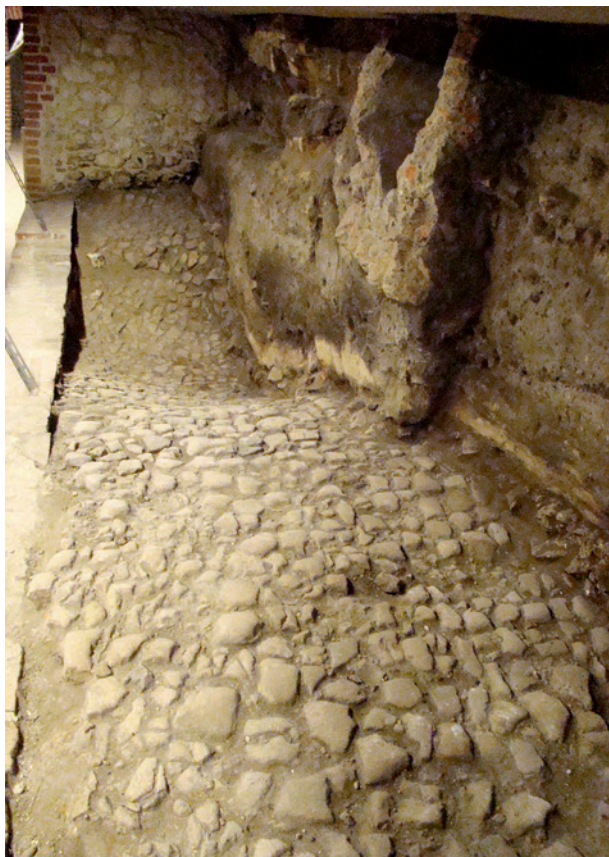
Ryc. 15. Północna część hali Sukiennic, wykop 34. Nawierzchnia bruku z początku XIV w. z głębokim, nieckowatym zagłębieniem kanału ściekowego. W głębi fundament kramów z drugiej połowy XIV w. (wschodnie skrzydło Sukiennic), z prawej kanał blokowy z XIX w. Widok od zachodu; fot. E. Zaitz
