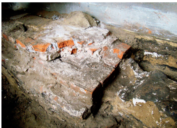
Ryc. 13. Północna część hali Sukiennic, wykop 34. Korona fundamentu renesansowego muru poprzecznego z zachowanymi resztkami ciosów wapiennych i piaskowcowych (z lewej) oraz nawierzchnia funkcjonującego przy nim bruku z charakterystycznym rynsztokiem (z prawej). Widok od północnego-zachodu; fot. E. Zaitz
