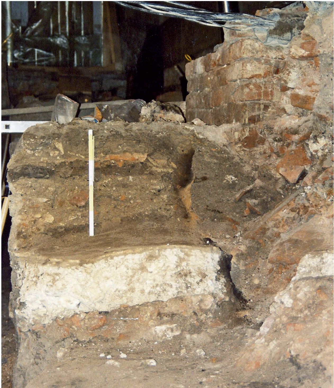
Ryc. 41. Zachodnia część krzyża Sukiennic, wykop 31 (odcinek D). Warstwa budowlana z XIV w. uformowana z zaprawy murarskiej, wapna i okruchów wapienia. Pod nią nasyp niwelacyjny z okruchów cegieł i dachówek oraz zaprawy murarskiej i szarego piasku. Na starannie wyrównanej powierzchni górnej cienka warstewka gliny pełniąca rolę klepiska. Z prawej fundament filara zbudowanego przez T. Prylińskiego oraz szczelina powstała po osunięciu ziemi do wykopu kanalizacyjnego z 1996 r. Widok od wschodu; fot. E. Zaitz
