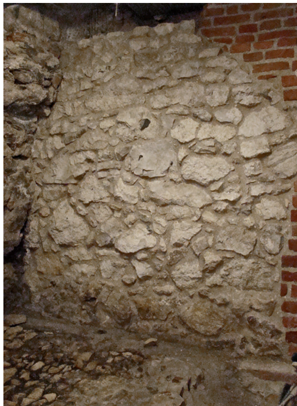
Ryc. 21. Północna część hali Sukiennic, wykop 34. Fundament zachodniego skrzydła Sukiennic z czytelną odsadzką fundamentową (u góry) oraz z zarysem wykopu budowlanego przecinającego bruk z początku XIV w. Z prawej ceglane łaty związane z wykonaniem korytarza łączącego podziemia pod wschodnią i zachodnią częścią Sukiennic. Widok od północnego-wschodu; fot. E. Zaitz
