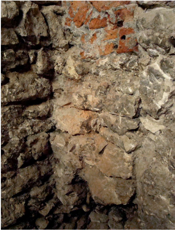
Ryc. 23. Północna część hali Sukiennic, korytarz, sonda 3. Wiązanie muru zachodniego skrzydła Sukiennic (z lewej) z częścią fundamentu zamykającego halę od północy (w środku), a także ślad etapowania budowy poprzez dostawianie fundamentu ściany północnej (z prawej) do zbudowanego już muru tego skrzydła. U góry ślad naprawy muru przy użyciu cegły maszynowej (osadzenie instalacji grzewczych c.o.). Widok od południowego-wschodu; fot. E. Zaitz
