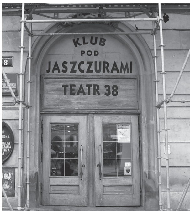
Oslonięta rusztowaniami kamienica „Pod Jaszczurami” przy krakowskim Rynku Głównym – miejsce wielu historycznych wydarzeń, dziś znana głównie z słynnego w całym kraju studenckiego Klubu Pod Jaszczurami (grudzień 2007), fot. A. Florkowska
