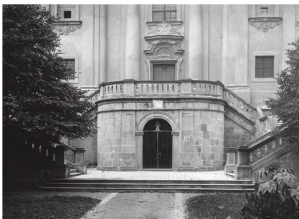
Dolna część fasady ze schodami i wejściem do krypty, ok. 1898, Zakład Fotograficzny „I. Krieger”, nr inw. MHK 1738/K
