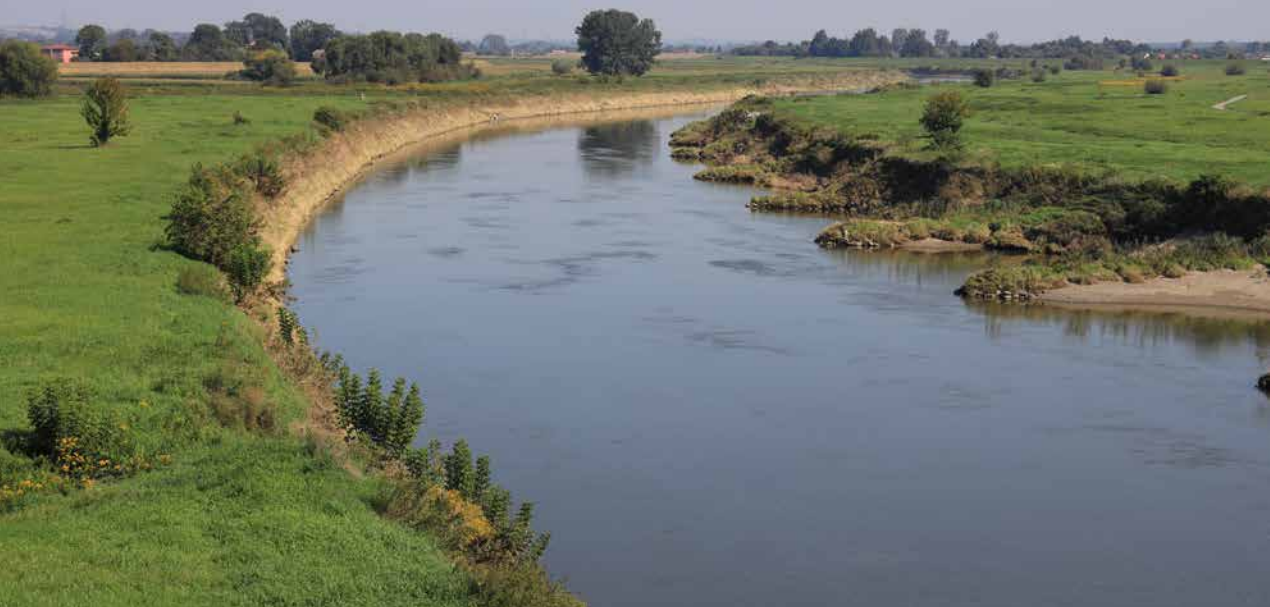
Widok z mostu Niepołomiczkiego na wschód. Wisła płynąca w głębokim korycie, w oddali na lewym brzegu widoczne ujście potoku Koscieleckiego, 2021, fot. Artur Rychta
