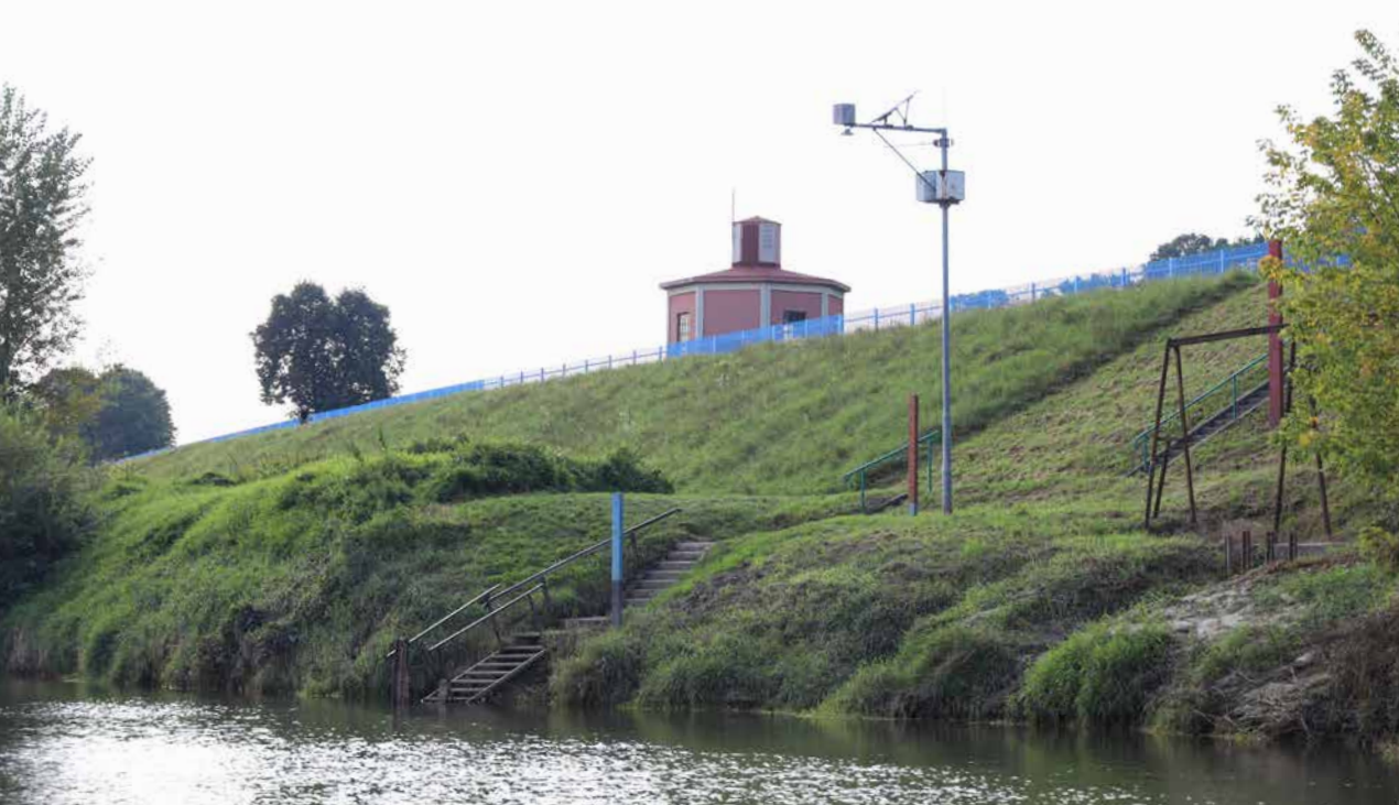
Bielany, wodowskaz IMGW i budynek kryjący zejście do tunelu technologicznego pod Wisłą, 2021, fot. Artur Rychta
