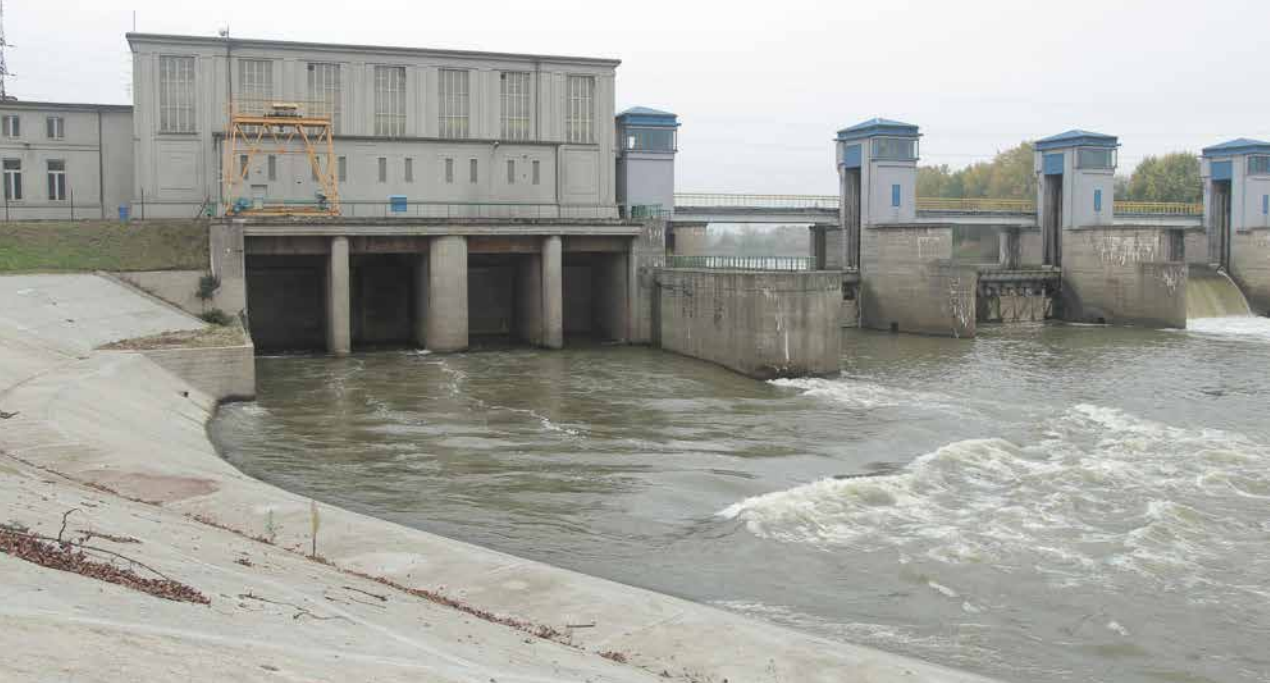
Elektrownia i stopień wodny Przewóz, 2020, fot. Artur Rychta
