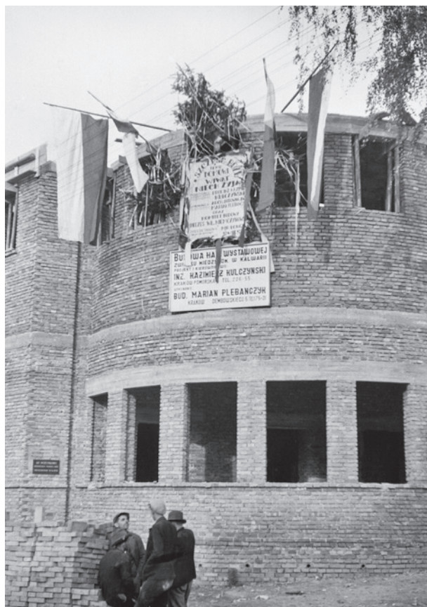
Ryc. 24. Budowa hali wystawowej w Kalwarii Zebrzydowskiej, fot. Marian Plebańczyk, 12 sierpnia 1938 r.; w zbiorach MK, nr inw. MHK-6464/N/2
