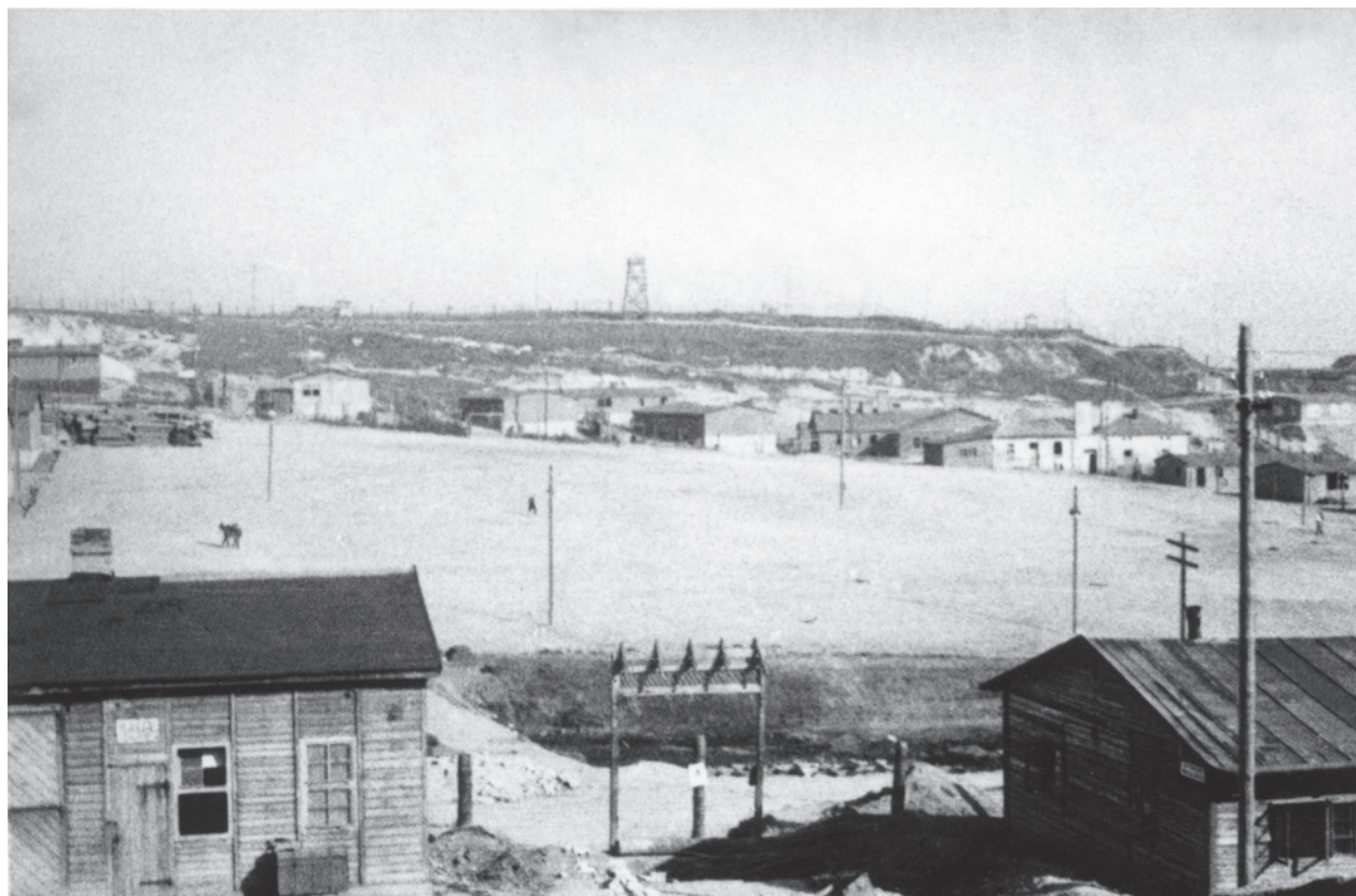
Plac apelowy obozu Płaszów. Na pierwszym planie z lewej barak warsztatów szewskich, z prawej warsztat zegarmistrzowski, za nim i w centrum staw przeciwpożarowy. Za placem apelowym baraki. Nad nimi widoczny kamieniołom II, grupa Auffangslager – baraki, obiekty łaźni i odwzalnii ( Entlausung ), poniżej baraki „polskie”. W rogu fragment szpitala SS. W centrum u góry wieża strażnicza; w zbiorach IPN, sygn. IPNKR-2-15-4-54
