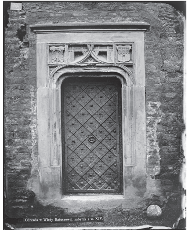
Ryc. 7. Portal wieży ratuszowej, fot. zakład Ignacego Kriegera, nie później niż 1878, negatyw szklany kolodionowy; w zbiorach MK, nr inw. MHK-2019/K
