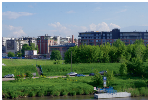
Ryc. 6. Zabudowa przy ul. Zabłocie 21, 23, 25, fot. Elżbieta Firlet, 17 maja 2019 r.; w zbiorach MK, DAU Pg., nr 5768
