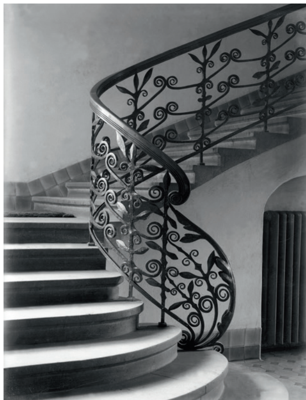
Ryc. 2. Klatka schodowa w budynku Muzeum przy ul. Smoleńsk 9, fot. pracownia fotograficzna Muzeum Przemysłowego, lata dwudzieste XX w.; w zbiorach MK, nr inw. MHK-251/N
