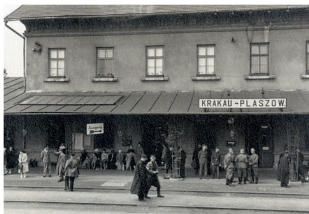
Wybudowany w latach 1883–1884 budynek dworca na stacji Kraków Płaszów widziany od strony torów, autor fotografii nieznan, 1939–1944; w zbiorach MK, nr inw. MHK-Fs22514/IX/188
