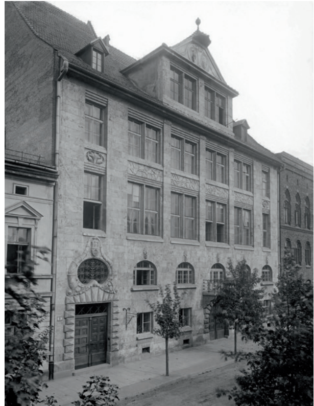
Ryc. 1. Fasada Muzeum Przemysłowego przy ul. Smoleńsk 9, fot. pracownia fotograficzna Muzeum Przemysłowego, lata dwudzieste XX w.; w zbiorach MK, nr inw. MHK-689/N
