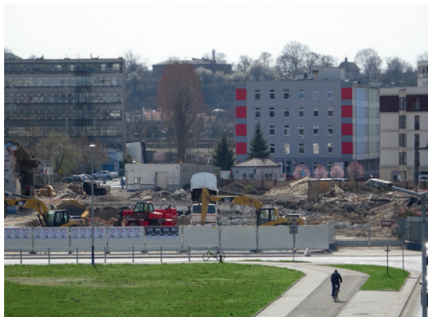
Ryc. 23. Wyburzenia przy ul. Zabłocie 21, fot. Elżbieta Firlet, 3 kwietnia 2016 r.; w zbiorach MK, DAU Pg., nr 00065
