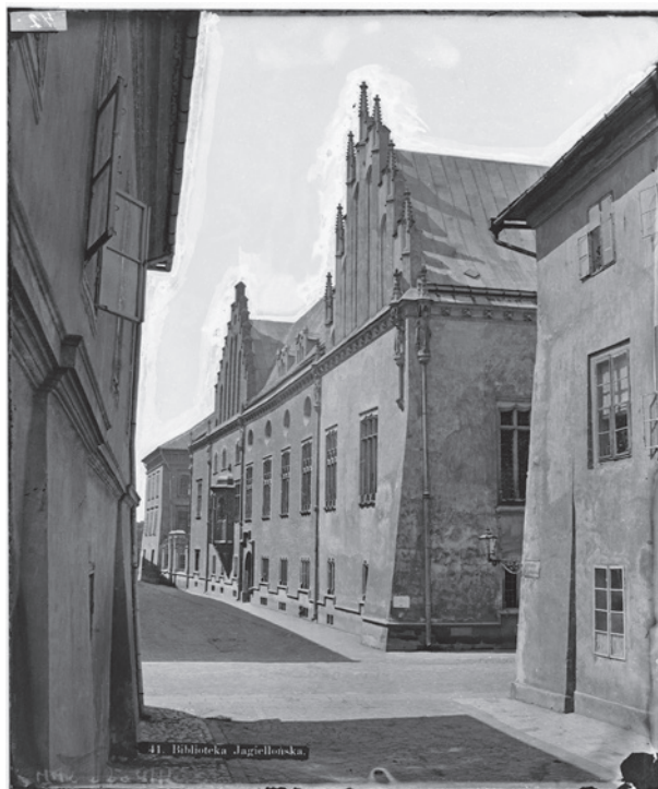
Ryc. 8. Collegium Maius od strony ul. Jagiellońskiej, fot. zakład Ignacego Kriegera, 1875, negatyw kolodionowy; w zbiorach MK, nr inw. MHK-2269/K
