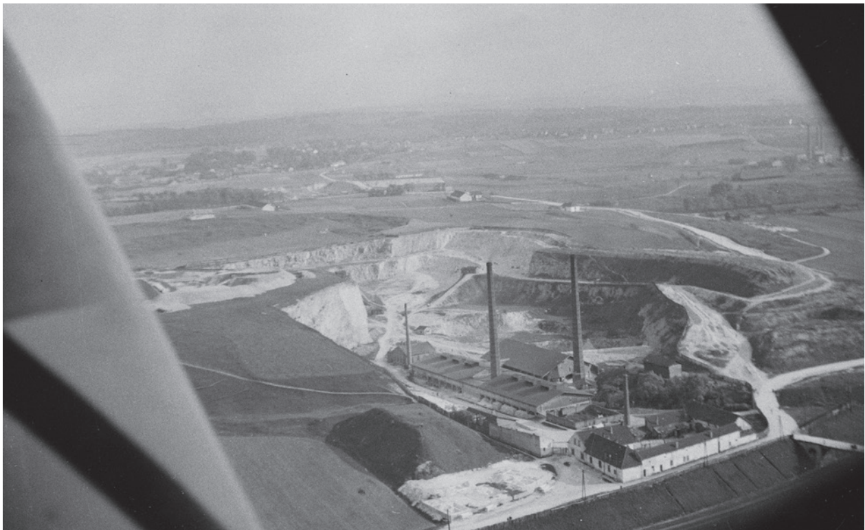
Ryc. 17. Widok z samolotu na kamieniołom Libana i nieistniejące dziś Zakłady Liban i Ehrenpreis, fot. Marian Plebańczyk, 15 czerwca 1936 r.; w zbiorach MK, nr inw. MHK-8663/N/15
