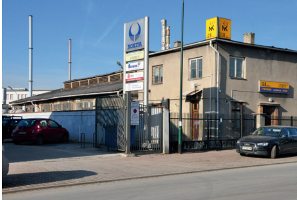
Ryc. 28. Cynkownia przy ul. Romanowicza 15, fot. Elżbieta Firlet, 7 lutego 2019 r.; w zbiorach MK, DAU Pg., nr 9627
