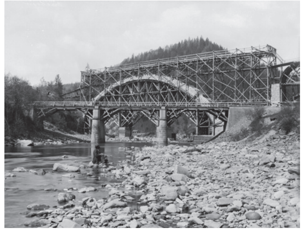
Ryc. 16. Budowa słynnego mostu kolejowego przez Prut w Jaremczy (Ukraina), dziś zastąpionego innym, zdjęcie wykonane na Powszechną Wystawę Krajową we Lwowie, fot. Natan Krieger, przed 1894; w zbiorach MK, nr inw. MHK-288/K
