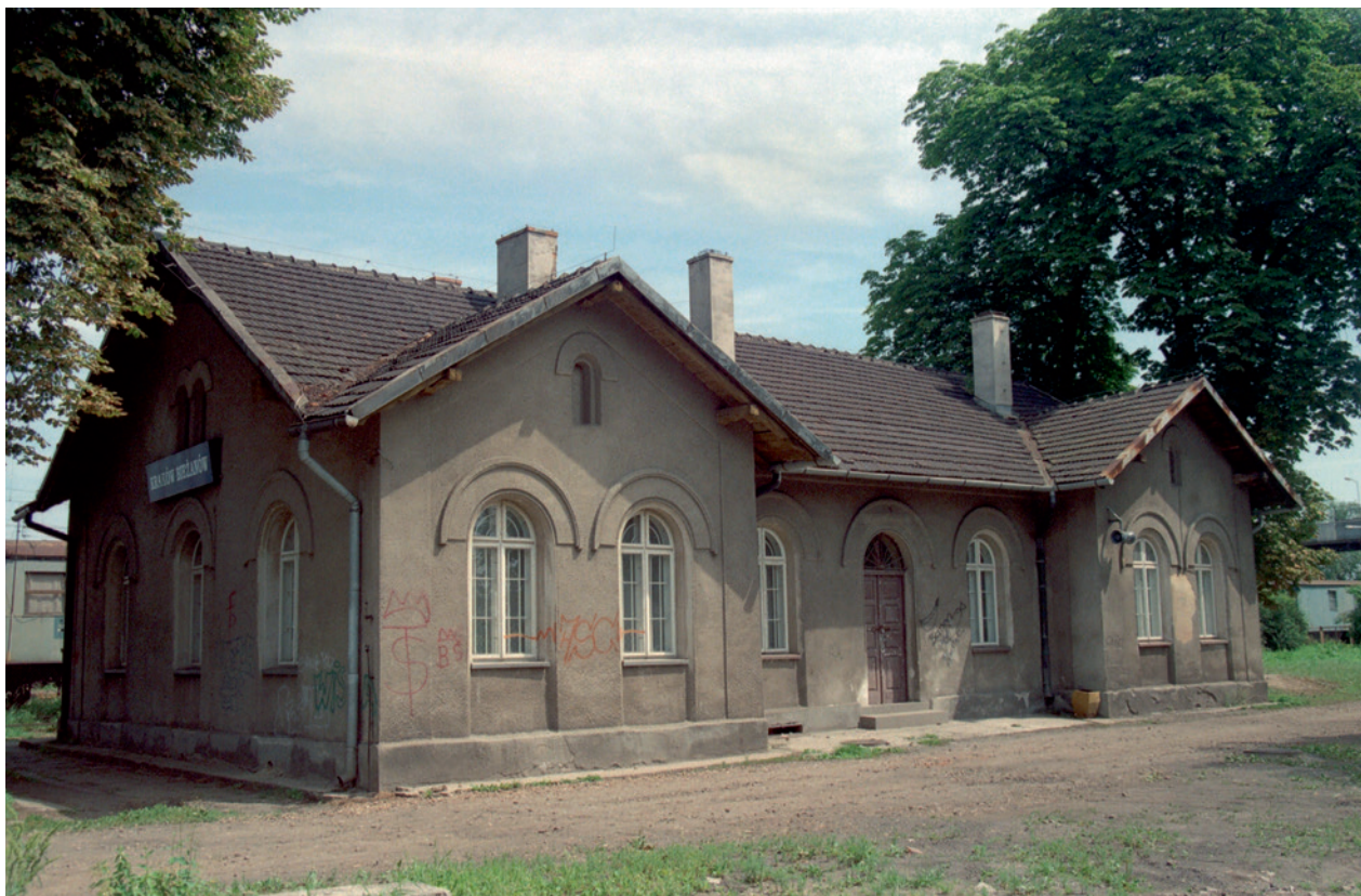
Dworzec w Bieżanowie do dziś zachował pierwotny kształt z połowy XIX w., fot. Elżbieta Firlet, 11 lipca 2001 r.; w zbiorach MK, nr inw. DAU PB 240
