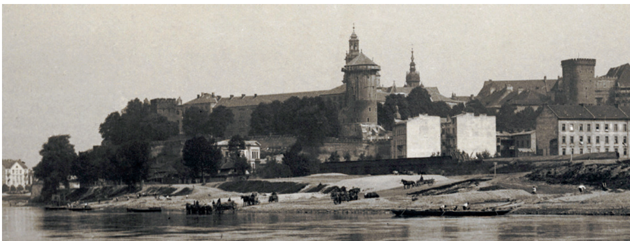
Ryc. 4. Ostatnie chwile podwawelskich Rybaków. Wykadowany fragment fotografii pokazującej budowę bulwarów wiślanych. Z lewej strony grupa domów i dworców, która tworzyła unikatowy zakątek Krakowa przy ulicach Rybaki i Bernardyńskiej. Ostatnie z nich zostały zburzone w 1914 r., fot. J. Misiński, 1913; w zbiorach MK, nr inw. MHK-Fs25/IX
