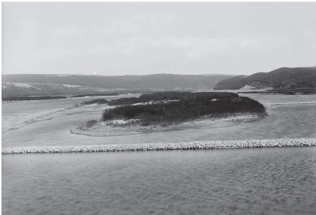
Ryc. 13. Regulacja Dniestru w okolicy miejscowości Niżniów (dziś Ukraina), zdjęcie wykonane na Powszechną Wystawę Krajową we Lwowie, fot. Natan Krieger, przed 1894; w zbiorach MK, nr inw. MHK-285/K
