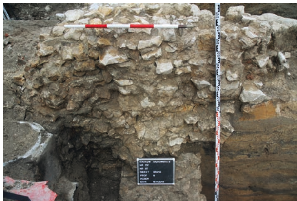
Strzępie południowego lica fragmentu muru obronnego Kazimierza (C) przebiegającego poprzecznie w stosunku do starszego, warstwowanego muru (A), równoległego do pierzei ul. Krakowskiej, fot. Piotr Cora, 2019
