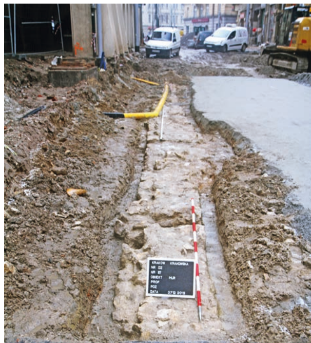
Odsłonięty pod nawierzchnią ulicy odcinek warstwowanego muru, równoległego do ściany elewacyjnej domów przy ul. Krakowskiej 5 i 7, widok ku północy, fot. Piotr Cora, 202
