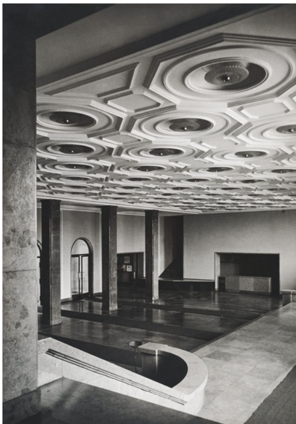
Ryc. 17. Hol główny w budynku administracyjnym Z Huty im. Lenina, autor fotografii nieznany, lata pięćdziesiąte – sześćdziesiąte XX w.; w zbiorach MK, nr inw. MHK-1079/XIIf/25
