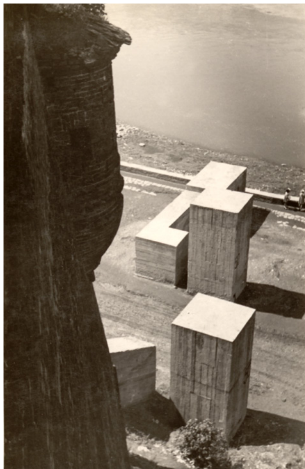
Niemieckie zapory przeciwpancerne ( Fallkörpersperre ) przy brzegu Wisły pod Wawelem, 1945, fot. Henryk Hermanowicz; w zbiorach MK, nr inw. MHK-Fs20319/IX/2
