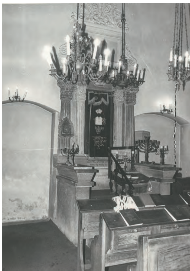
Ryc. 15. Wnętrze synagogi Remu, 1988, autor fot. nieznanym; nr inw. MHK-Fs11557/IX
