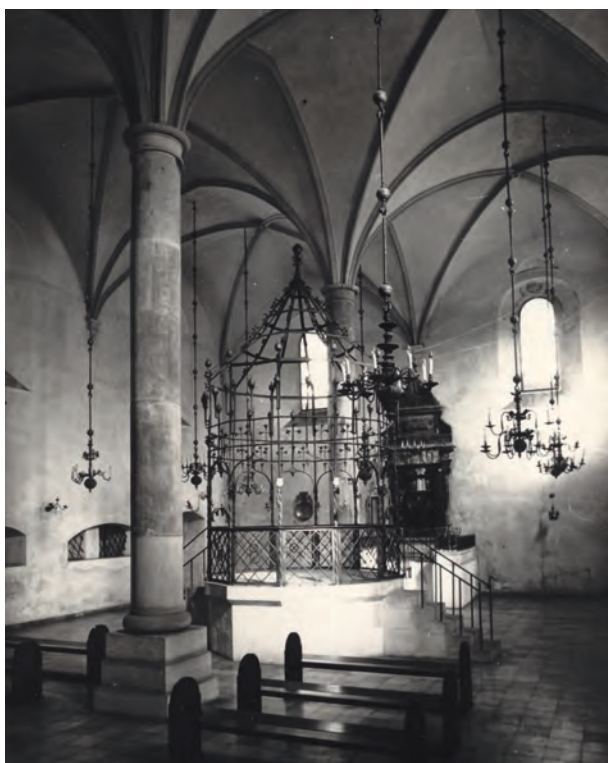
Ryc. 22. Wnętrze głównej sali modlitewnej w Starej Synagodze, 1965, fot. Daniel Zawadzki; nr inw. MHK-Fs20698/IX/3
