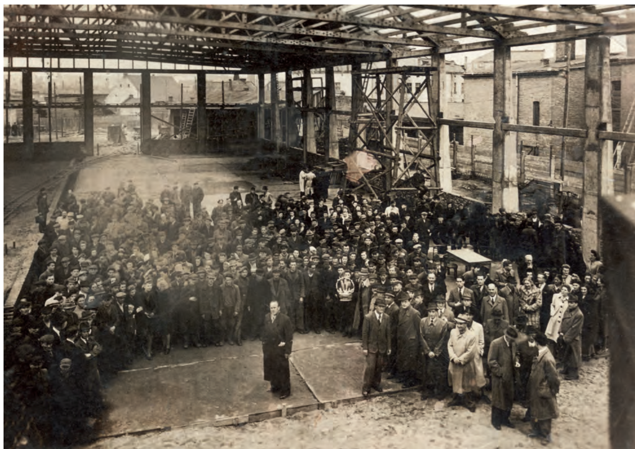
Ryc. 11. Oskar Schindler z pracownikami w czasie budowy jednej z hal fabrycznych przy ul. Lipowej 4, 1943, autor fot. nieznanymi; nr inw. MHK-Fs19680/IX
