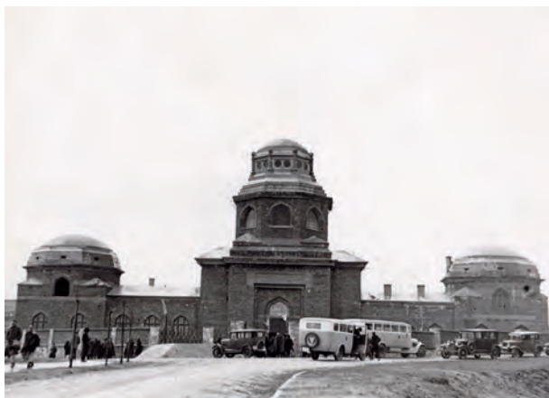
Ryc. 47. Dom przedpogrzebowy na nowym cmentarzu żydowskim przy ul. Abrahama, 1932, fot. AF „Światowid”; nr inw. MHK-Fs5876/IX
