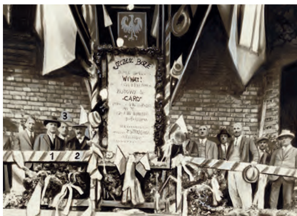
Ryc. 76. Uroczystość wiechy na budowie gmachu spółki Caro, 16 sierpnia 1928 r., fot. AF „Światowid”; nr inw. MHK-Fs1525/IX
