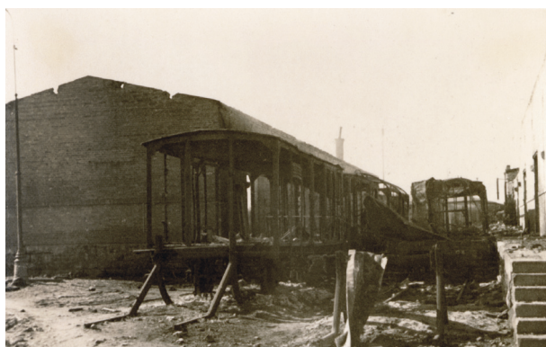
Zniszczenia na dworcu kolejowym, autor fotografii nieznanym; w zbiorach MHK, nr inw. MHK-Fs18227/IX-4
