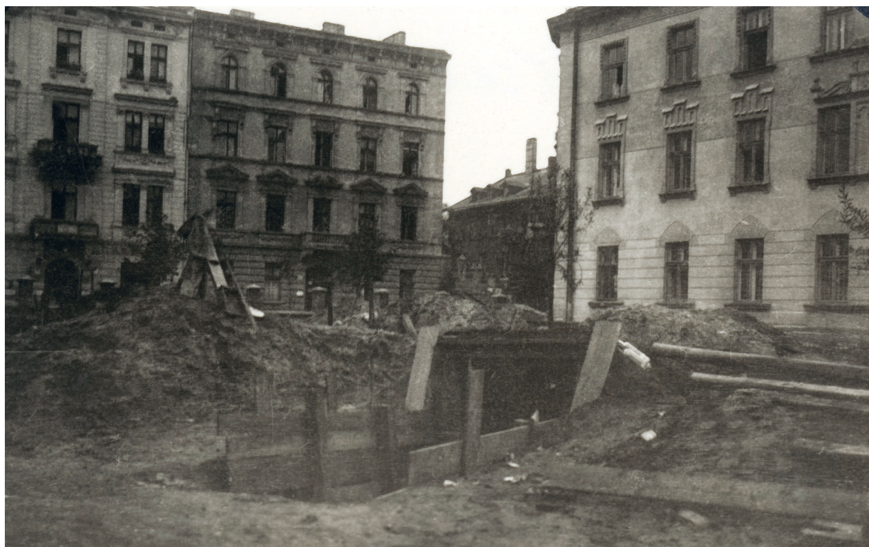
Schron przeciwlotniczy przy dworcu kolejowym, autor fotografii nieznanym; w zbiorach MHK, nr inw. MHK-Fs21993/IX-6
