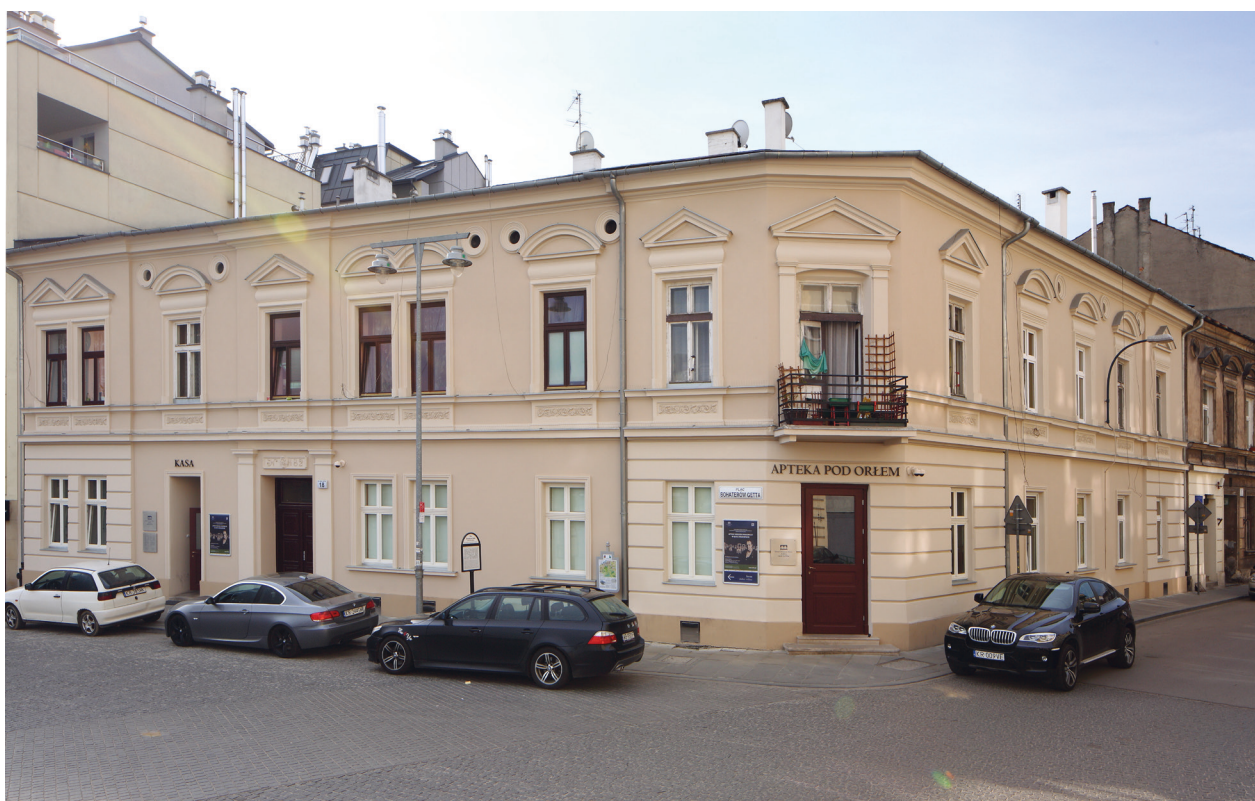
Kamienica przy placu Bohaterów Getta 18 po remoncie w 2013 r.; fot. Andrzej Janikowski
