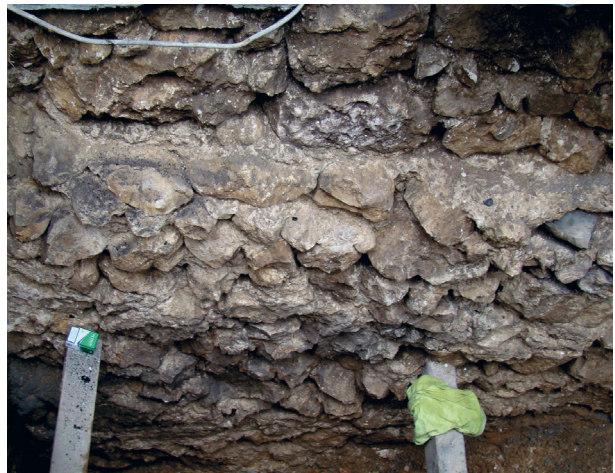
Ryc. 39. Dziedziniec zachodni. Kamienny fundament w południowej partii zachodniego skrzydła klasztoru (I faza budowy) z zaznaczoną lokalną odsadzką na jego koronie. Widok od zachodu; fot. Emil Zaitz
