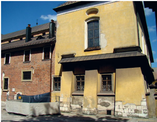
Ryc. 37. Dziedziniec zachodni. Południowa część zachodniego skrzydła zabudowań klasztornych (II faza) z barokowymi przyporami oraz ceglana elewacja starszego budynku (I faza). Widok od zachodu; fot. Emil Zaitz
