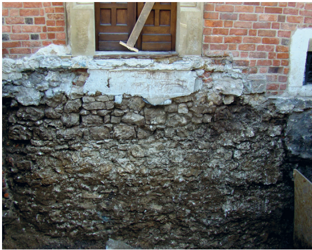
Ryc. 38. Dziedziniec zachodni. Kamienny fundament zachodniego skrzydła klasztoru (I faza budowy) w rejonie wejścia do furty. Widok od zachodu; fot. Emil Zaitz
