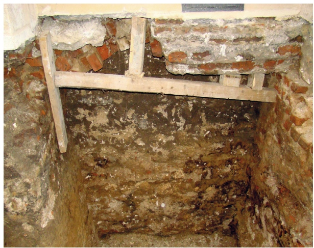
Ryc. 40. Dziedziniec zachodni. Fundament południowej partii zachodniego skrzydła klasztoru (II faza budowy) odkryty pomiędzy murami barokowych przypór. Widok od zachodu; fot. Emil Zaitz
