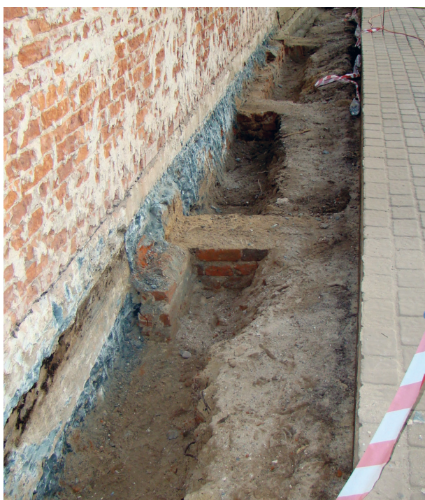
Ryc. 12. Chodnik przy ul. Klasztornej. Wykop budowlany wzdłuż parkanu z odkrytymi koronami ceglanych murów oficyny. Na wschodniej ścianie budynku posadowiony został obecny parkan. Widok od północy; fot. Emil Zaitz
