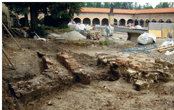
Ryc. 29. Środkowa część dziedzińca. Relikty murów mostu funkcjonującego nad młynówką. Na pierwszym planie południowa część zachodniego przyczółka, w głębi budowla arkadowa (z podcieniami) zamykająca dziedzińiec od strony ogrodów klasztornych. Widok od południa; fot. Emil Zaitz
