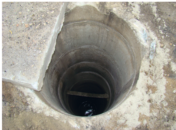
Ryc. 19. Południowa część dziedzińca. Studnia zlokalizowana w południowo-wschodniej części placu przyszpitalnego, koło pierwotnego (?) koryta młynówki. Na początku XX w. wymieniono jej cembrowinę na betonowe kręgi, zaś w latach 70. nakryto betonową płytą. Widok od północy; fot. Emil Zaitz
