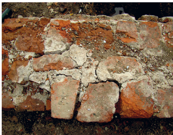
Ryc. 31. Środkowa część dziedzińca, partia zachodnia. Korona muru zachodniego przyczółka mostu z wtórnie użytymi półówkami trapezowatych cegieł. Widok od wschodu; fot. Emil Zaitz
