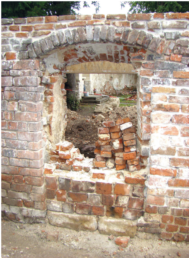
Ryc. 24. Środkowa część dziedzińca. Otwór drzwiowy w południowej ścianie lazaretu, odtworzony w murze z początku XX w., naśladowującym mur gotycki. Z budowli gotyckiej zachowała się tylko dolna partia ceglanych węgarów oraz resztki kamiennego progu. Widok od południa; fot. Emil Zaitz
