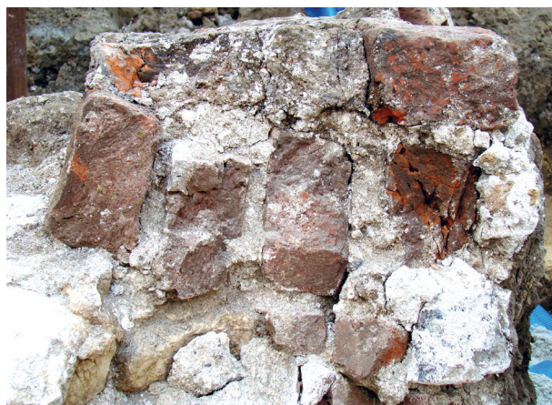
Ryc. 35. Dziedziniec przy zachodniej ścianie kościoła. Relikty ceglonej ściany zachowanej na koronie filara renesansowego przedsionka (kruchty). Czytelna warstwa wyrównawcza z pionowo ułożonych cegieł (tzw. rolka). Widok od północy; fot. Emil Zaitz
