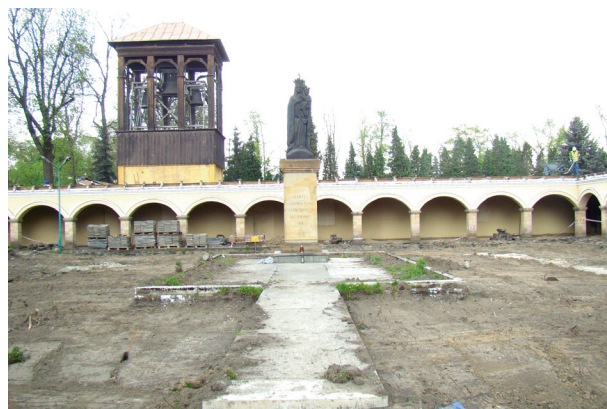
Ryc. 15. Północna część dziedzińca. Teren dawnego ogrodu po rozebraniu nawierzchni i pierwszym etapie korytowania odsłaniającym strop nadcalcowej warstwy humusowej. W głębi budynek arkadowy (z podcieniami) z początku XX w. oraz dzwonnica. Widok od południa; fot. Emil Zaitz
