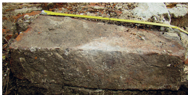
Ryc. 31. Środkowa część dziedzińca, partia zachodnia. Korona muru zachodniego przyczółka mostu z wtórnie użytymi półówkami trapezowatych cegieł. Widok od wschodu; fot. Emil Zaitz
