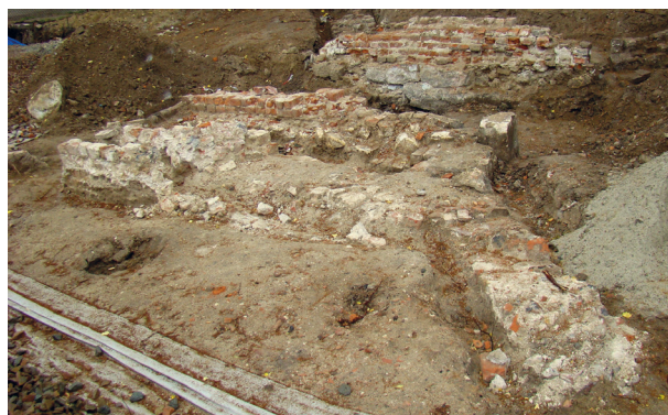
Ryc. 28. Środkowa część dziedzińca. Relikty murów mostu nad korytem młynówki, który umożliwiał przejście z drogi w miejscu obecnej ul. Klasztornej na teren dawnego placu przykościelnego. Widok od północnego wschodu; fot. Emil Zaitz
