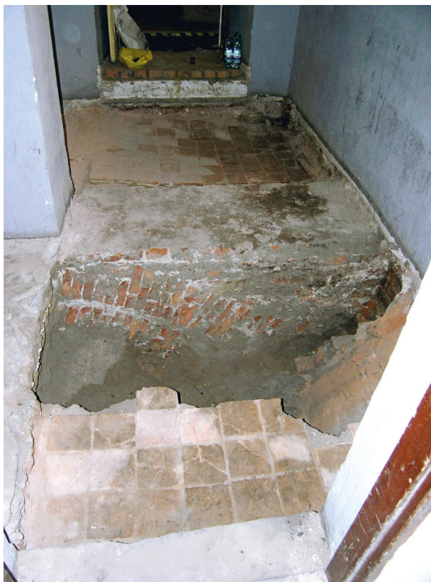
Parter, klatka schodowa, ujęcie w kierunku zachodnim. Pod poziomem ostatniej podłogi częściowo zachowana posadzka ceramiczna. Na przedłużeniu ściany między biegami schodów, nad grzbietem sklepienia piwnicznego, łuk konstrukcyjny, fot. Ł. Holcer
