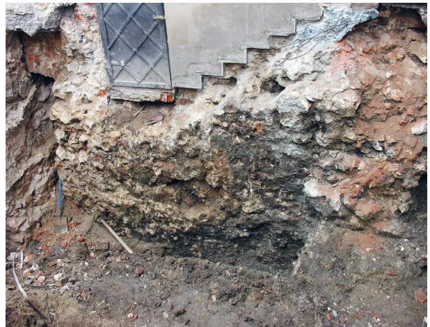
Wykop na dziedzińcu przy elewacji wschodniej. Poniżej rozebranego zejścia do piwnic mur z kamienia łamanego, zakończony od strony południowej narożnikiem. Między narożnikiem a fundamentem przypory rozpięty łuk ceglany, fot. Ł. Holcer
