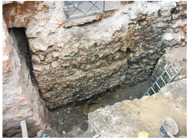
Wykop na dziedzińcu przy elewacji wschodniej. W kamiennym murze pionowa cesura. Z prawej strony (pod drabiną) kamienny fundament pod kanałem blokowym, dostawiony do muru wschodniego, fot. Ł. Holcer
