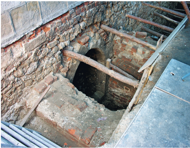
Wykop przy elewacji północnej. Pierwotne zejście do budynku z kamiennym portalem. Po bokach otworu dostawione mury oporowe, wzniesione z grubej cegły palcowanej, fot. Ł. Holcer
