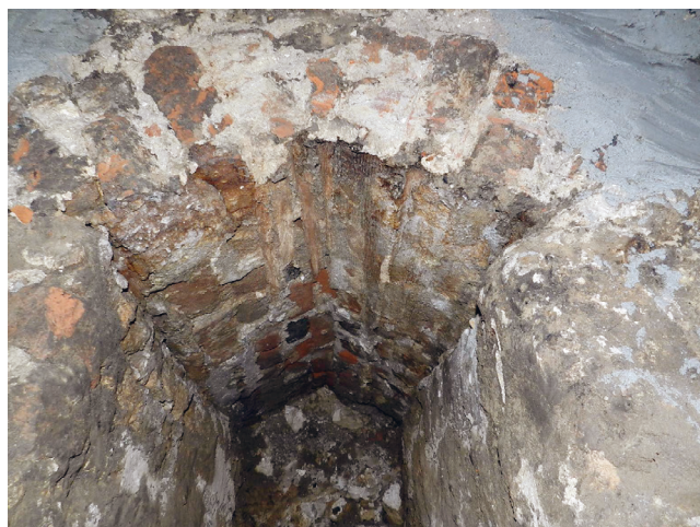
Wykop po przejeździe na dziedziniec. W kamiennym murze zamkniętym najstarszy dom od strony południowej, na głębokości 5,23 m p.p.t. wąski kanał. W ceglany, trójkątnie uformowanym zamknięciu ślady po deskowaniu i pozostałości drewna, fot. E. Holcer
