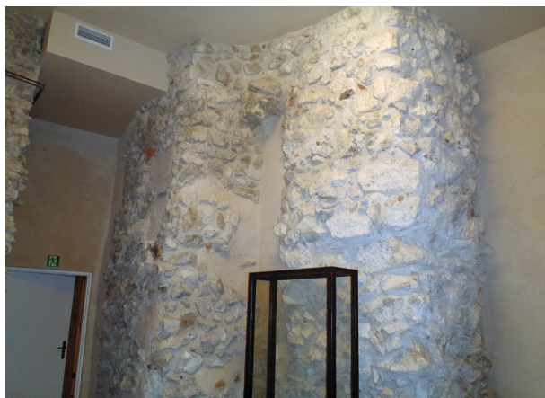
Widok kamiennego stupa wzmacniającego konstrukcję budowli w piwni- cach, 2012, fot. K. Glanowska
