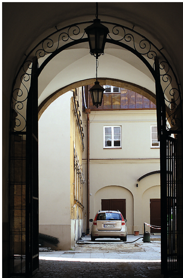
Widok oficyny po remoncie od strony ul. Szczepańskiej, 2012, fot. A. Gawrońska
