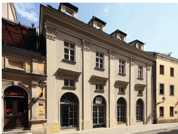
Fasada budynku przy ul. Jagiellońskiej 4 po konserwacji, 2012, fot. T. Kalarus
