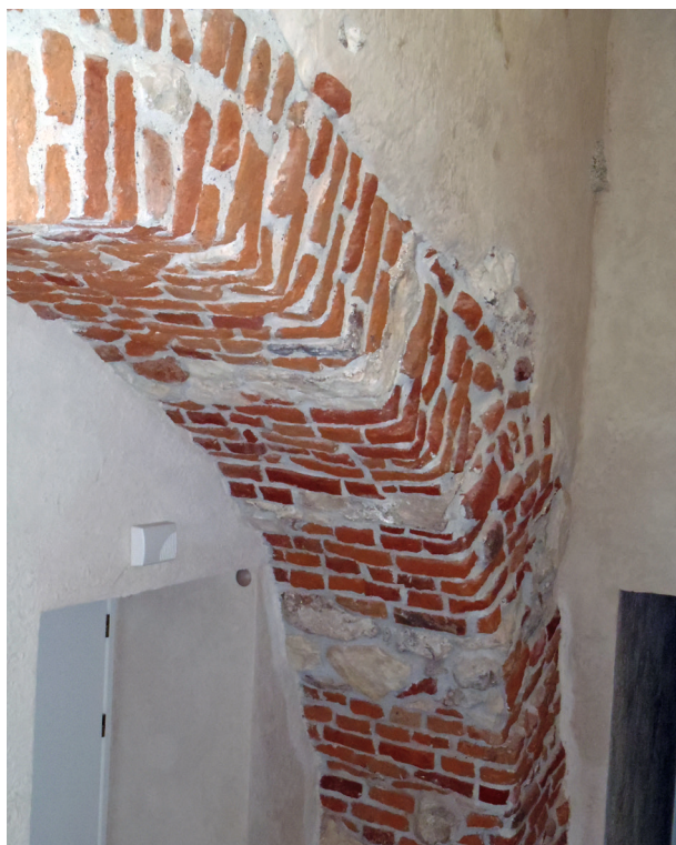
Ekspozycja starszych relikwów budowli w piwnicach; fragment ceglano- łęgu, 2012, fot. K. Glanowska
