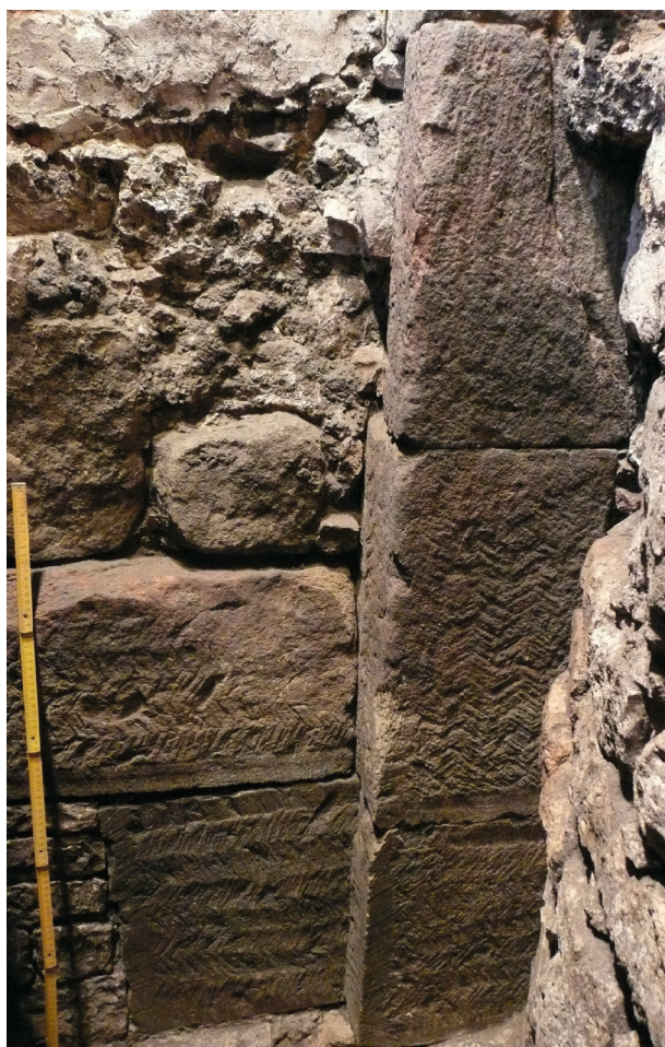
Odsłonięta część ciosowego oblicowania prezbiterium (cokół i lizena), z bogatą obróbką kamieniarską, fot. J. Firlet
