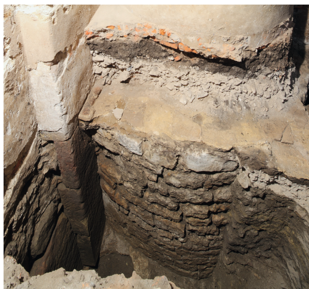
Narożnik południowo-zachodni zakrystii (sonda nr 1), odsłonięta część apsydy romańskiej przy prezbiterium, na koronie wylewka posadzki, fot. T. Kalarus, A. Janikowski
