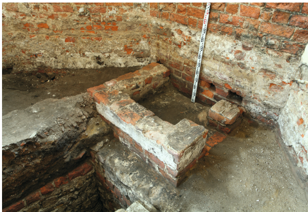
Zakrystia (kaplica), zachowana część ołtarza w prezbiterium, z lewej strony fragment grobowca, fot. T. Kalarus, A. Janikowski
