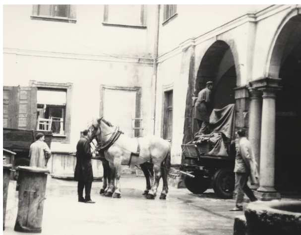
Przeprowadzka do pałacu Pod Krzysztofony – na dziedzińcu, ok. 1966, autor fot. nieznanym
