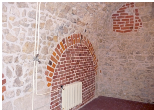
Kamienica Hipolitów – ściana działowa piwnic po konserwacji; fot. A. Bohan, 2009 r.
