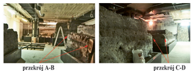
Ryc. 8. Umiejscowienie lokalizacji świadka B2 w podziemiach Rynku w aneksie północnym, przekrój przez warstwy świadka, z lewej strony, w głębi, ściana zachodnia podziemi, z prawej strony widok wzdłuż rozciągłości świadka B2, w głębi ściana południowa podziemi; fot. M. Wardas
