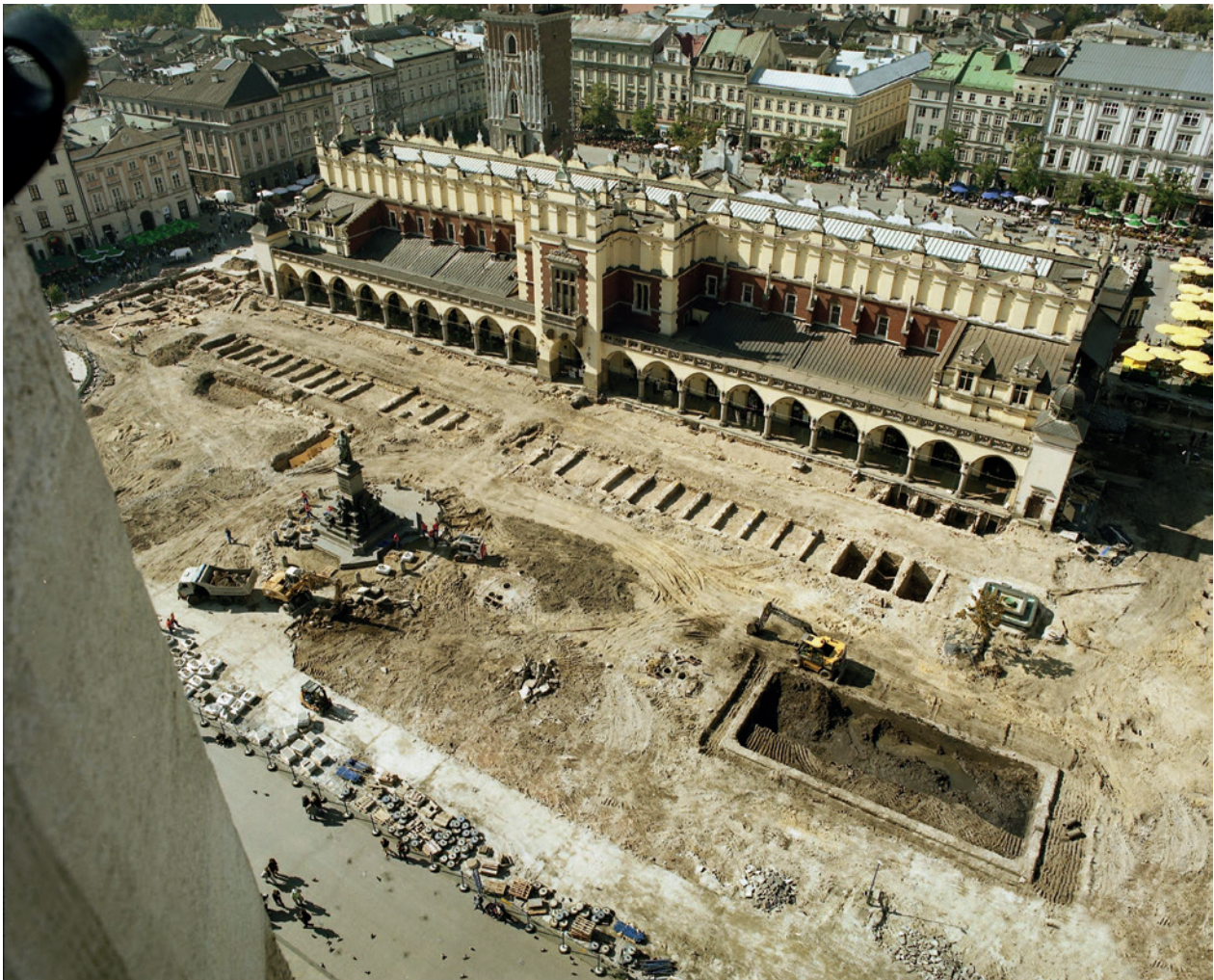
Wschodnia część Rynek Głównego. Przed Sukiennicami widoczne korony murów Kramów Bogatych, stan z 2005 r.; fot. T. Kalarus
