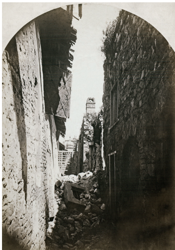
Miedzuch między Sukiennicami i Kramami Bogatymi, widok w kierunku północnym. Z prawej strony mur magistralny Kramów Bogatych; fot. Zakład Fotograficzny Walerego Rzewuskiego w Krakowie, 1868 r.; reprodukcja w zbiorach Biblioteki Jagiellońskiej, sygn. I. F. 7792
