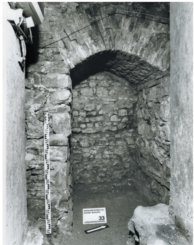
Kramy Bogate – ćwiartka północno-zachodnia, piwnica pierwszego kramu od północy (nr 33). Nizowy fundament podcienia Sukiennic (T. Pryliński), dostawiony do zachodniego muru kramów z fazy III (w głębi); fot. T. Kalarus
