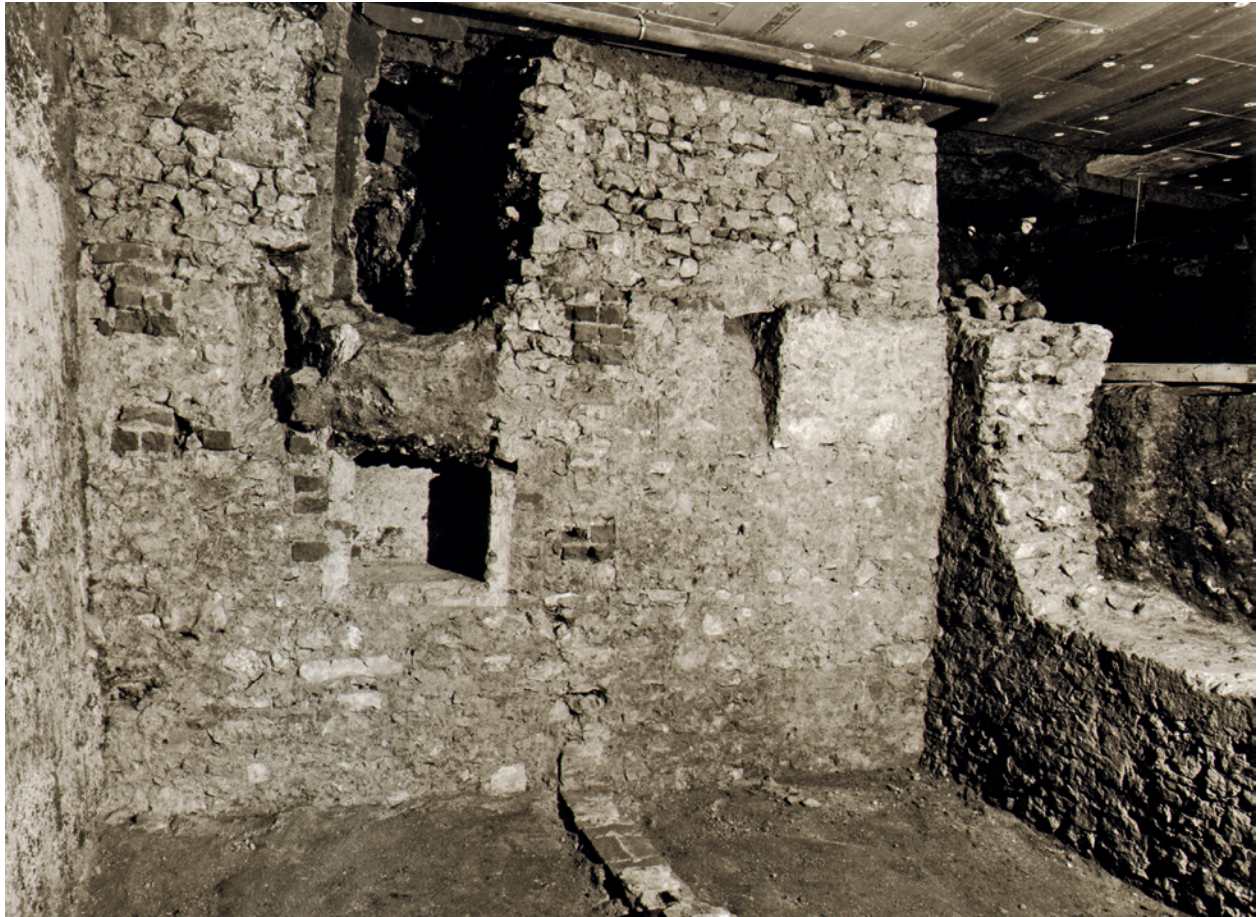
Mury kramów z fazy I, odkryte po północnej stronie krzyża. Z prawej strony mur południowy, w głębi relikty wschodniego muru z fazy I (z wnęką i szybkami okien), na którym stoi mur wschodniego ciągu Kramów Bogatych z fazy III, w dole relikty ściany działowej z fazy I; fot. T. Kalarus
