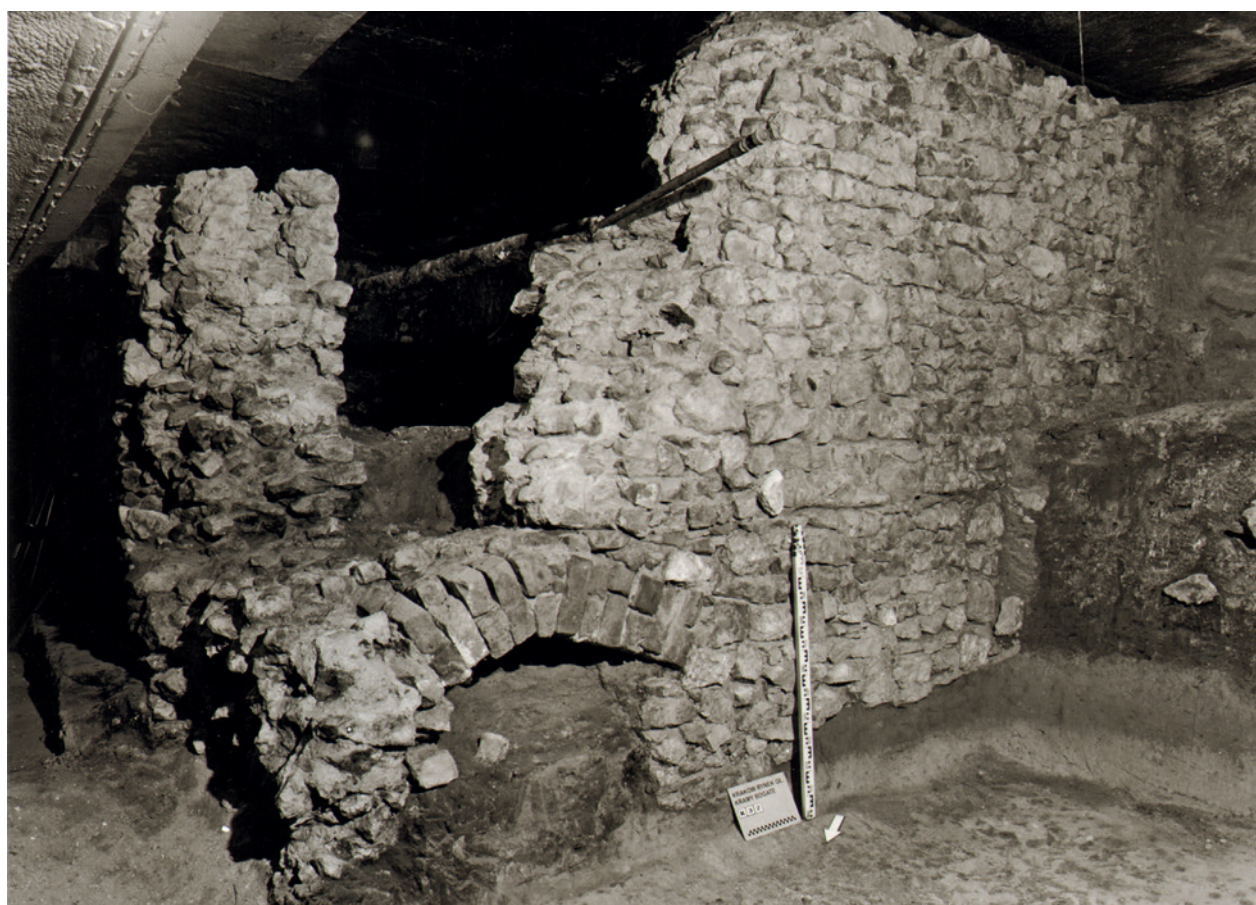
Północno-zachodni narożnik wschodniego ciągu Kramów Bogatych (faza III). Widoczny kamienny wąż murów magistralnych oraz ceglany łęk fundamentowy, założony nad podziemnym, drewnianym ściekiem; fot. T. Kalarus
