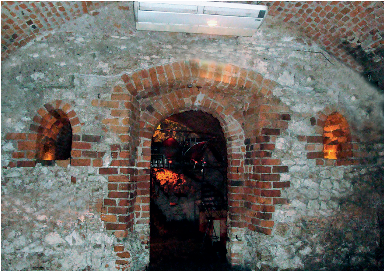
Ulica Bracka 3/5, piwnice – wnętrze pierwszej kondygnacji domu wieżowego wójta Henryka, ściana elewacyjna wschodnia, koniec XIII w.; fot. M. Łukacz
