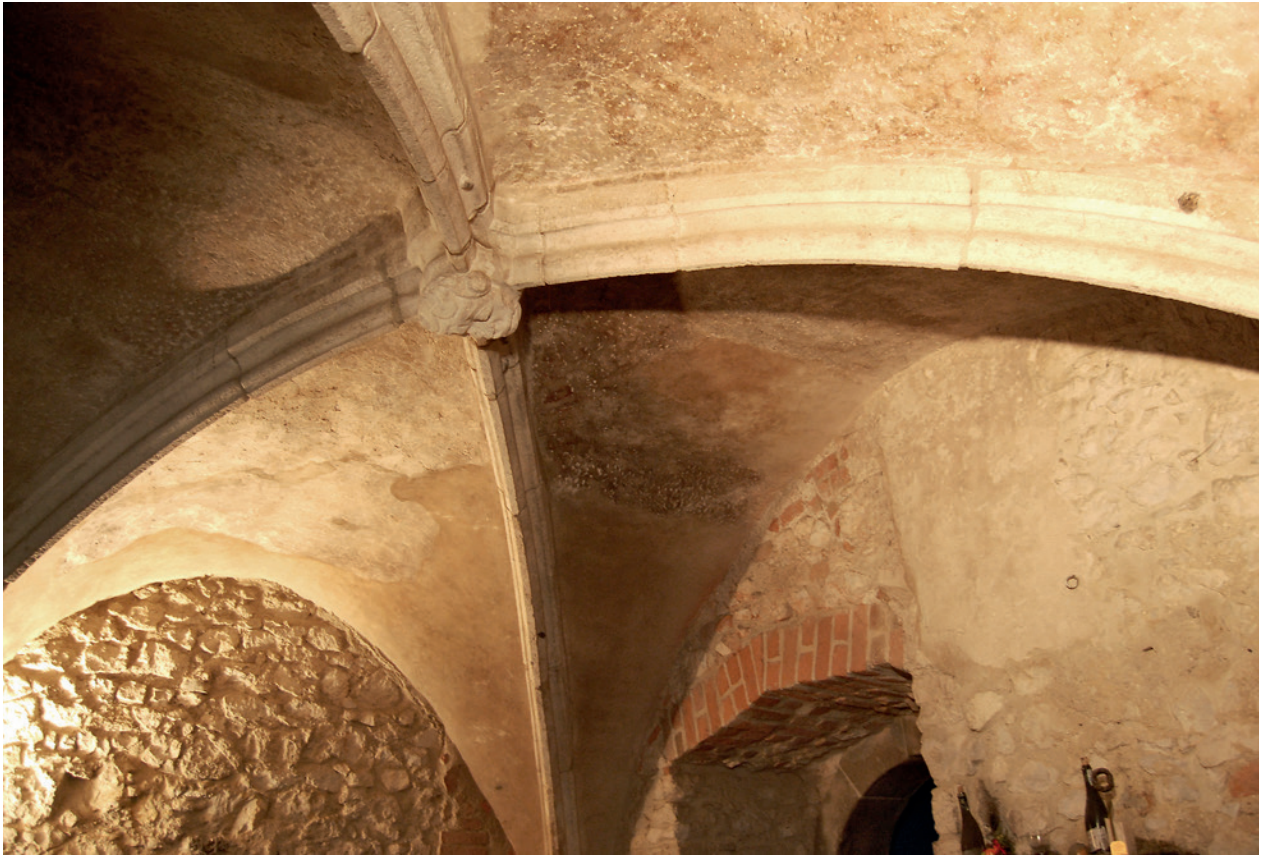
Rynek Główny 23, piwnica traktu frontowego – przeszło sklepienia żebrowego z przedstawieniem głowy męskiej w zworniku, połowa XIV w.; fot. M. Łukacz
