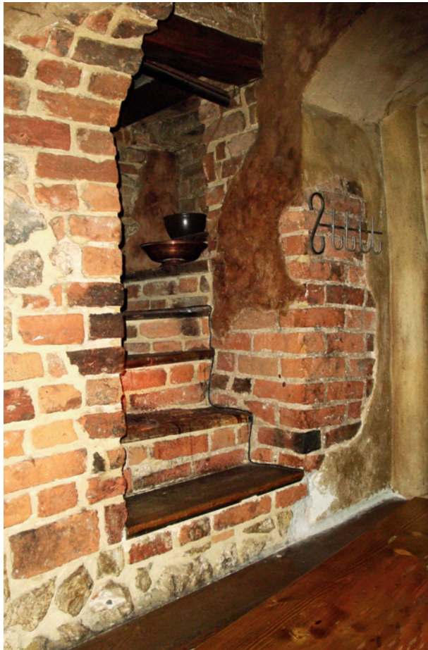
Rynek Główny 6, piwnice – schody w grubości muru pierwotnej ściany elewacyjnej tylnej narożnego budynku, prowadzące z podwórca na piętro, początek XIV w., drewniane stopnice późniejsze; fot. M. Łukacz
