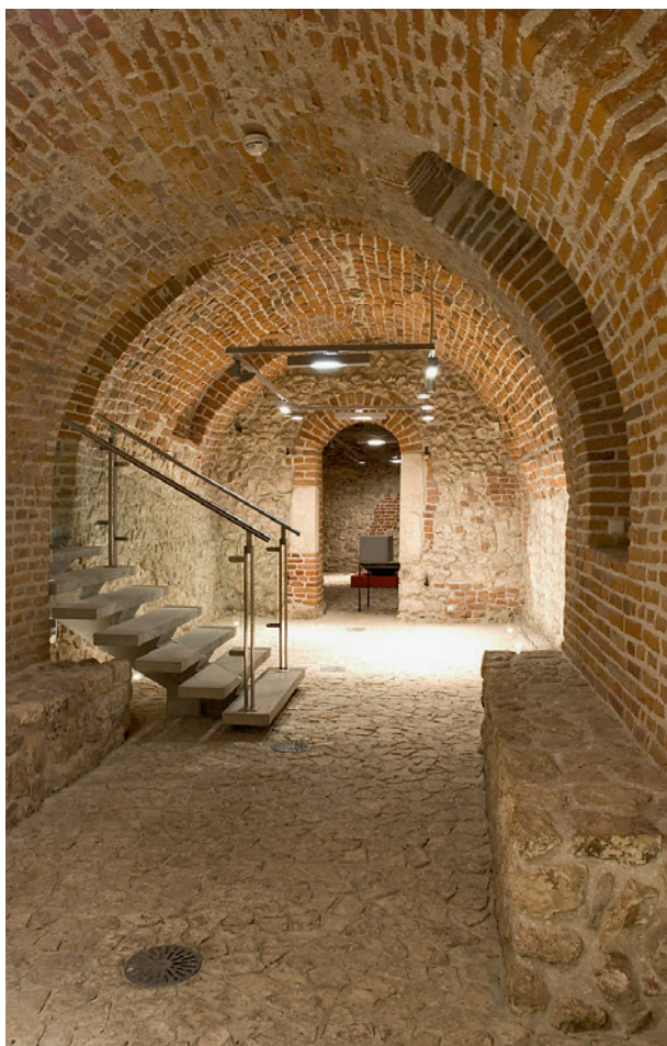
Rynek Główny 35, piwnice – wnętrze przedproży, druga połowa XIV w.; fot. D. Bodzioch
