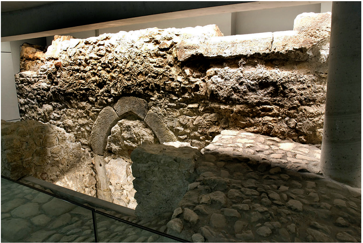
Rynek Główny 35 (siedziba Muzeum Historycznego Miasta Krakowa), piwnice – ściana elewacyjna przedproża, widoczny portal wyjścia z południowego przedproża na Rynek, druga połowa XIV w.; fot. D. Bodzioch
