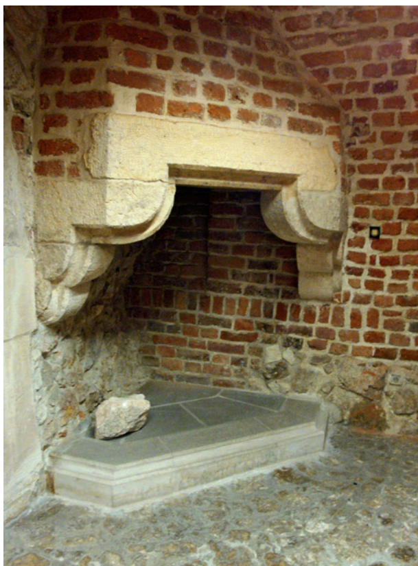
Rynek Główny 20, piwnica traktu frontowego – kominek o kotarowym nadprożu, pierwsza połowa XV w., palenisko rekonstruowane; fot. M. Łukacz
