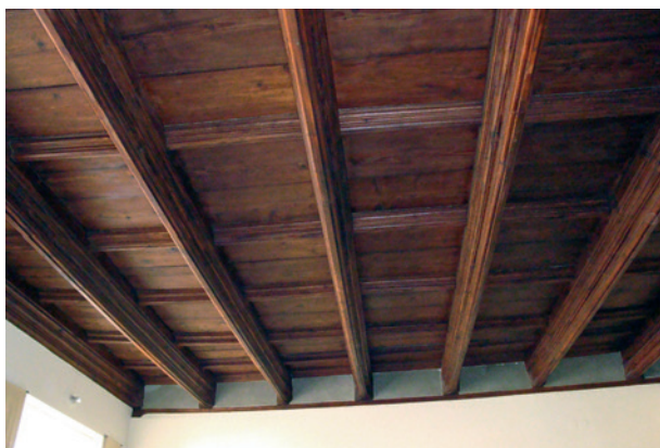
Rynek Główny 19, pierwsze piętro – trakt frontowy, profilowany strop belkowy o diagonalnym układzie beleczek, koniec XV w.; fot. M. Łukacz
