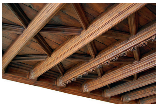
Rynek Główny 19, pierwsze piętro, trakt frontowy – profilowany strop belkowy, kasetonowy, połowa XV w.; fot. M. Łukacz
