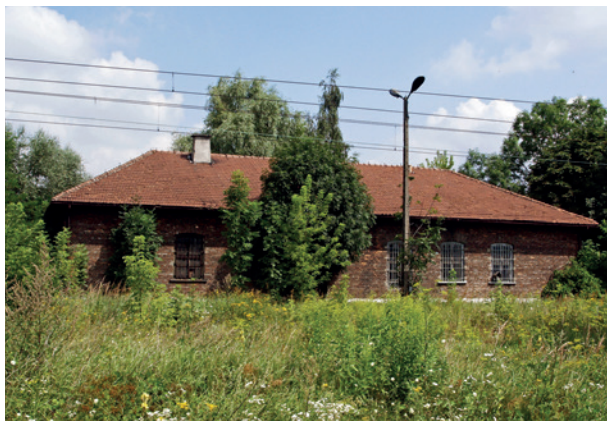
Wybudowany podczas wojny obiekt infrastruktury technicznej Prokocimia Towarowego: budynek pompowni wodnej (hydroforni) zasilającej wieżę ciśnieni, fot. D. Lulewicz, 2009
