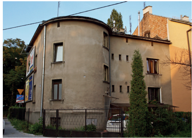
Budynek świetlicy i stołówki dla pracowników stacji Kraków-Płaszów (ul. Prokocimska 53 A), obecnie budynek mieszkalny, fot. D. Lulewicz, 2009
