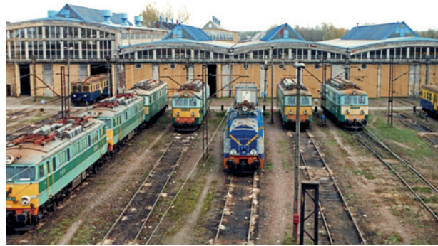
Ukończona i znacznie rozbudowana po wojnie hala zachodnia lokomotywowni Kraków-Prokocim – dawniej parowozowni Krakau Ost, położona we wschodniej części stacji rozrządowej, fot. W. Dykas, 2000
