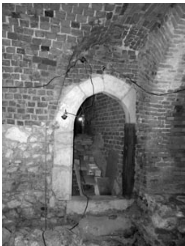
Ryc. 13. Fragment elewacji frontowej domu z IV fazy. Portal wtórnie osadzony. Nad kamiennym wątkiem sklepienie z XIV-wiecznej cegły, fot. Ł. Holcer
