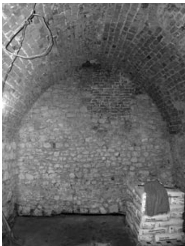
Ryc. 30. Północna ściana komory północnej przedproży. W kamiennym wątku zamurowany otwór dawnego okna otwartego w kierunku ul. Sławkowskiej. Ceglane sklepienie nieco wyostrzone w kluczu, fot. L. Holcer
