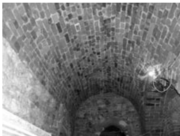
Ryc. 25 Ceglane sklepienie z XIV-wiecznej cegły nad помещением z fazy VI. W głębi kamienna, zewnętrzna zachodnia ściana domu z fazy IV. Po prawej ceglana arkada jednoczesna z kolebką sklepienia, fot. Ł. Holcer
