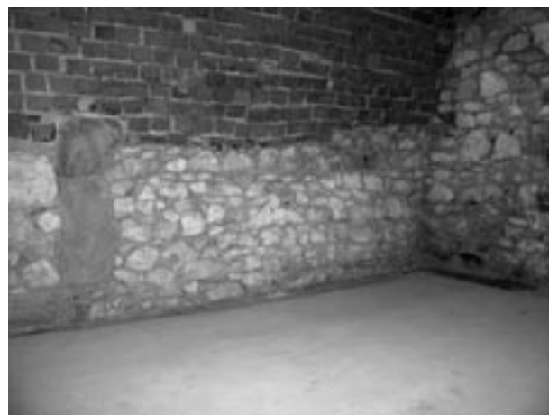
Ryc. 12. Kamienny wążek elewacji frontowej domu z fazy III, widziany od strony przedproży w południowej komorze. Fragment portalu z piaskowca w dawnym wejściu; ceglane sklepienie w wieku XIV, fot. L. Holcer
