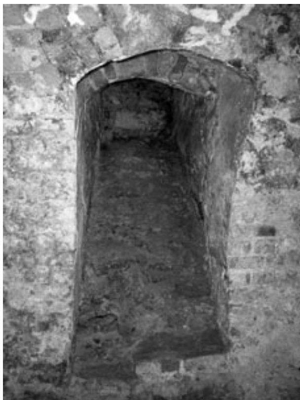
Ryc. 14. Okno zachodnie w północnej ścianie pomieszczenia z fazy IV. Otwór o kamiennych ościeżach i ceglany, odcinkowym wysklepku. Luneta w późniejszym sklepieniu dostosowana do pierwotnego otworu, fot. Ł. Holcer
