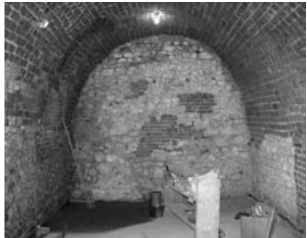
Ryc. 29. Południowa, kamienna ściana południowej komory przedproży. W kolebce sklepienia zaslepiony otwór dawnego okna (zejścia?) wychodzącego na Rynek, fot. D. Bodzioch
