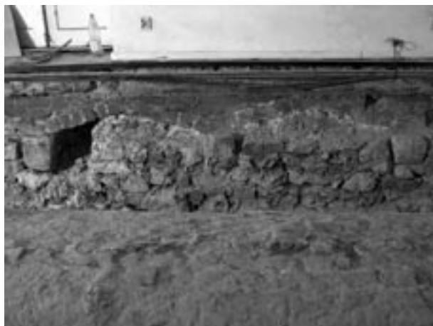
Ryc. 20. Południowa ściana domu z fazy V odsłonięta pod posadzką sieni. Szereg, przelamanych w kluczu, ceglanych przęseł wspartych na kamiennych konsolach, fot. D. Bodzioch
