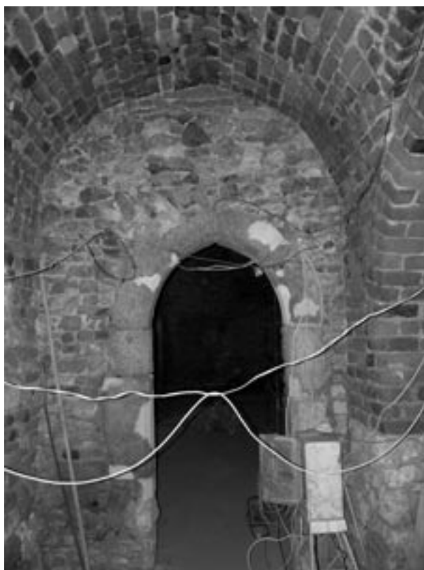
Ryc. 32. Portal w kamiennym wątku zachodniej, zewnętrznej elewacji budynku z IV fazy. Wyżej późniejsze sklepienie z 2 połowy XIV wieku, fot. L. Holcer
