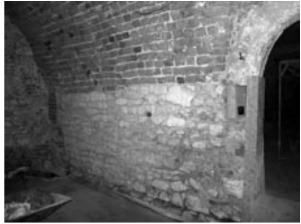
Ryc. 28. Południowo-zachodnia część północnej komory przedproży. Z prawej układ kamiennego wątku dawnej, frontowej elewacji domu z fazy IV. Kolebka sklepienia z cegły XIV-wiecznej, fot. Ł. Holcer
