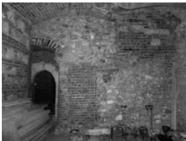
Ryc. 16. Ściana wschodnia w pomieszczeniu z fazy IV. Wtórny portal w wyjściu z budynku, wyżej ceglane nadproże pierwotnego otworu. W górnej części ściany kamienne glify dawnych otworów, fot. Ł. Holcer
