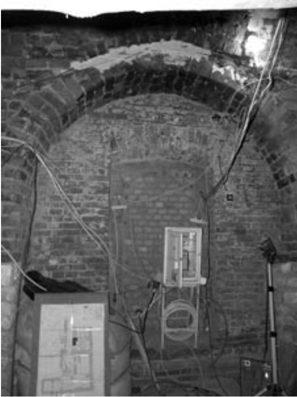
Ryc. 27. Ceglana arkada rozpięta między opłaszczowanym narożnikiem obiektu XIII-wiecznego, a zachodnią elewacją budynku wzniesionego w IV fazie
