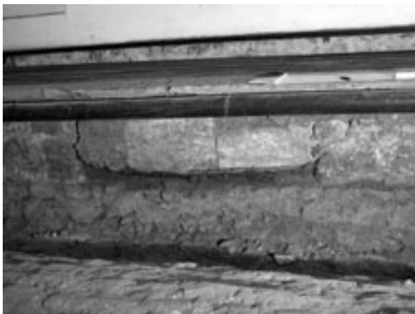
Ryc. 3. Fragment drugiej kondygnacji północnej ściany domu XIII-wiecznego, odsłonięty pod posadzką sieni. Dolna część zamurowanego otworu wejścia, fot. D. Bodzioch
