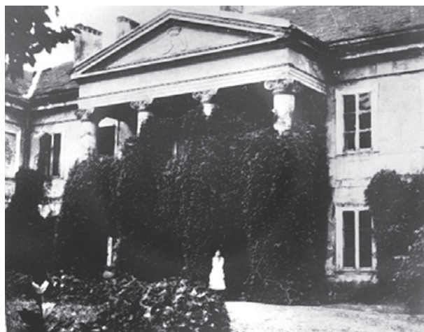
Fasada pałacu Wodzickich w Kościelnikach, 1909, aut. fot. niezn., wł. Nowina Konopkowie
