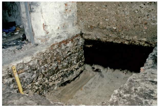
Ryc. 14 Kraków – Piasek, klasztor oo. Karmelitów, wnętrze dobudówki przy wschodniej ścianie oficyny, wykop XIII; północno-zachodnia partia wykopu z fundamentem ściany oficyny i murem południowym dobudówki, poniżej dawna warstwa humusowa i calc; fot. J. Firlet
