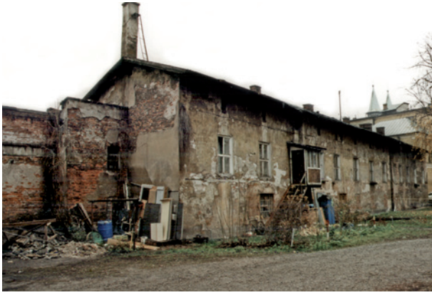
Ryc. 5. Kraków – Piasek, klasztor oo. Karmelitów, widok budynku oficyny od strony dziedzińca gospodarczego; fot. J. Firlet
