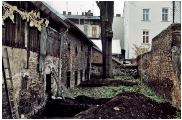
Ryc. 7. Kraków – Piasek, klasztor oo. Karmelitów, teren pomiędzy północną ścianą dawnej wozowni a murem granicznym klasztoru, w trakcie badań w wykopach XVI i XVII, fot. E. Zaitz
