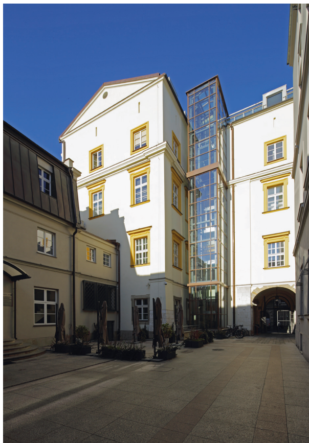
Widok skrzydła zachodniego od strony dziedzińca, w narożniku oszklony szyb windy, fot. Tomasz Kalarus, październik 2015 r.
