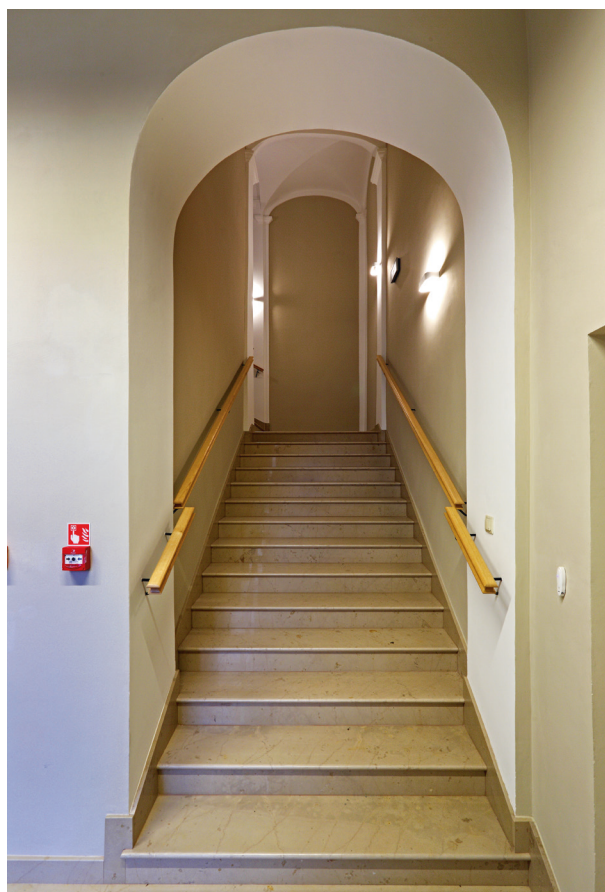
Klatka schodowa w nowej aranżacji kolorystycznej, z nowymi marmurowymi stopnicami, fot. Tomasz Kalarus, październik 2015 r.
