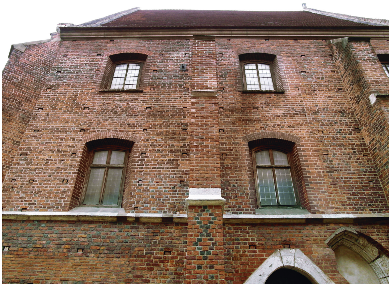
Ryc. 8. Kościół św. Marka w Krakowie, fragment elewacji południowej z oknami doświetlającymi empore, fot. Magdalena Goras
